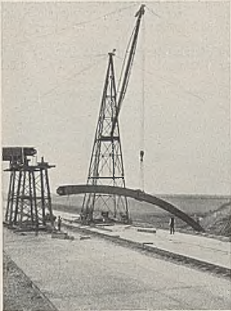
Abb. 35. Bauzustand 2. Einheben einer Bogenhälfte.
