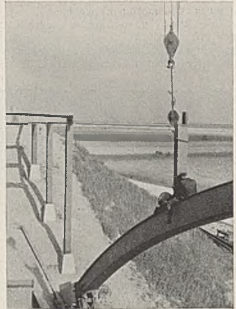
Abb. 38. Befestigen einer Stütze am Bogen.
