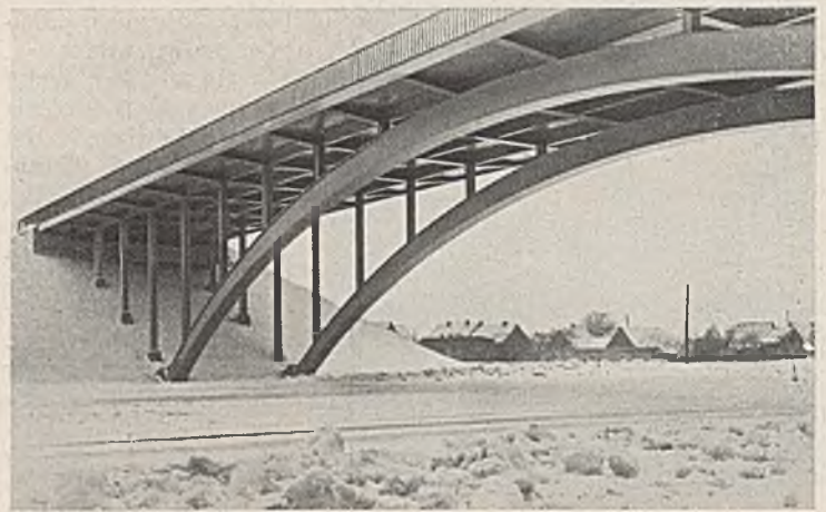
Abb. 41. Untersicht Bauwerk Ds 13.
