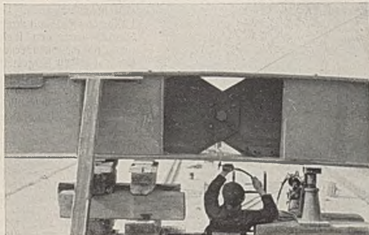
Abb. 36. Behelfsgelenk in Bogenmitte.
