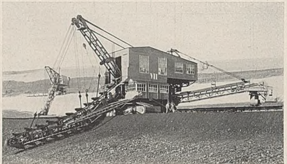
Abb. 4. Der mit einem Raupenfahrwerk und einem Abwurförderband versehene Eimerkettenbagger (Abb. 3) nach dem Umbau. Bauart Lübecker M.-G.
