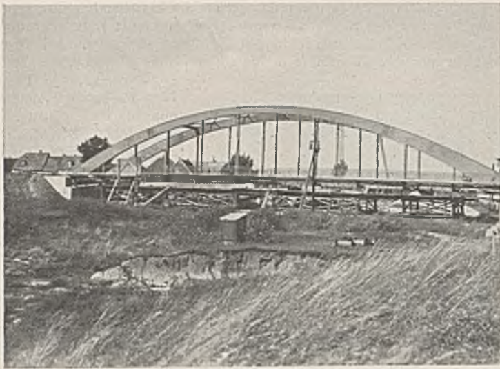
Abb. 55. Straßenbrücke Merseburg—Leipzig über den Merseburger Durchstich.
