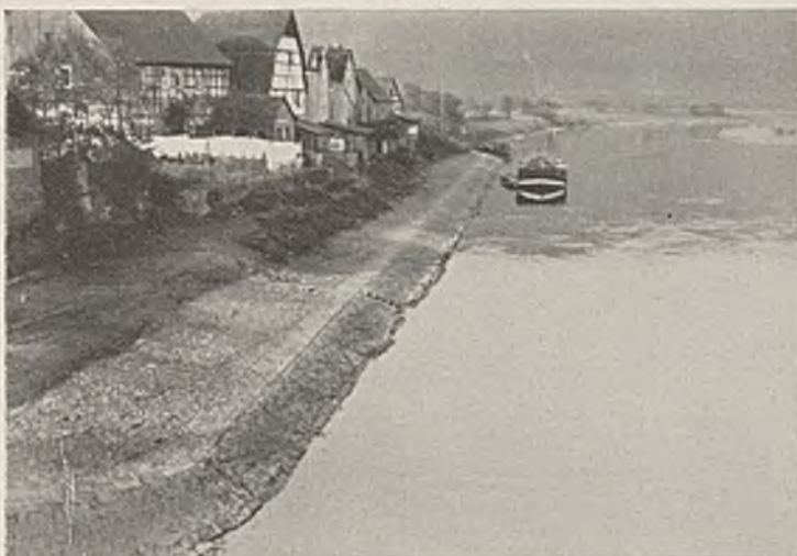
Abb. 63. Uferdeckwerk bei Gieselwerder.
