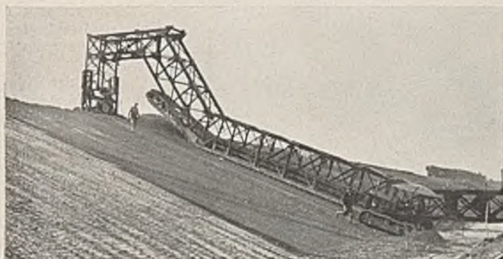
Abb. 52. Kratzband für den Toneinbau.
