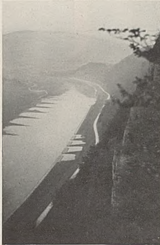
Abb. 64. Niedrigwasserregulierung bei Pegestorf.
