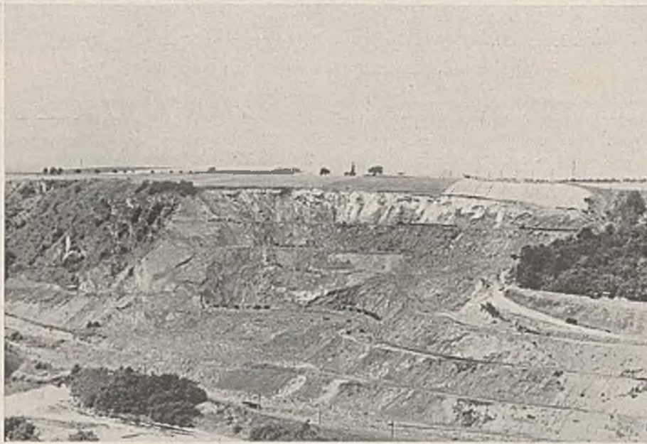
Abb. 57. Rutschgebiet am Oberkanal der Schleuse Rothenburg.
