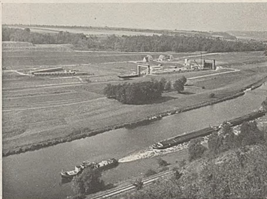
Abb. 58. Gesamtüberblick über die Schleuse Rothenburg. Im Vordergrund die Saale.
