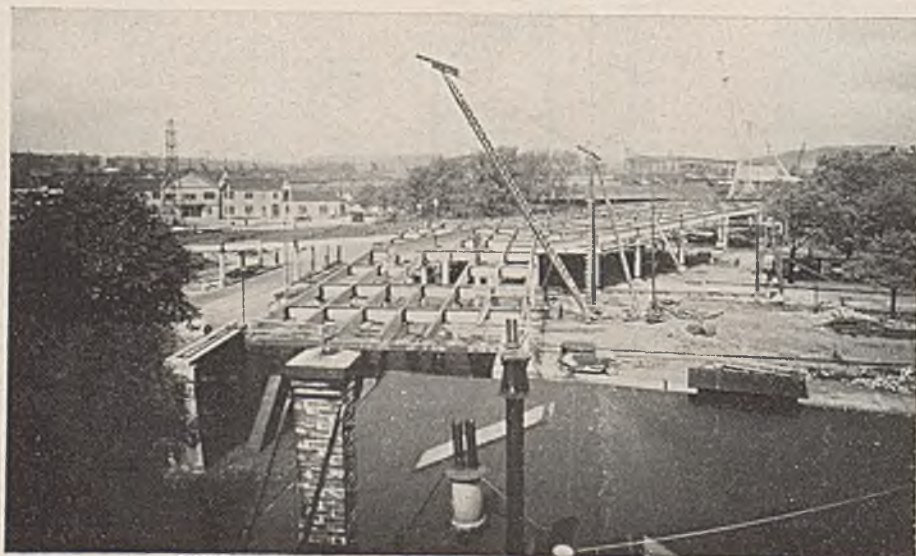
Abb. 45. Montage der Südrampe am Stützdreieck.
