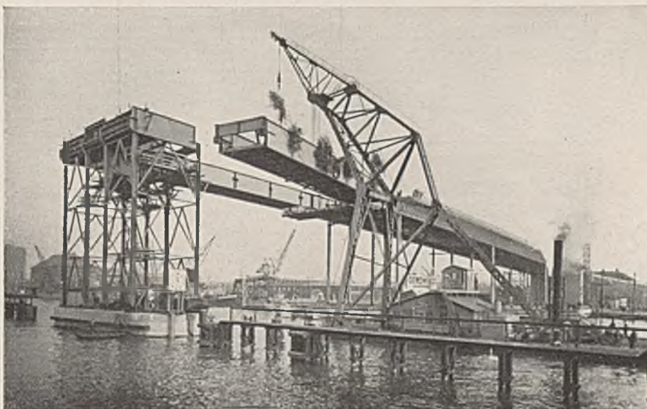
Abb. 31. Einsetzen des letzten Überbaues.
