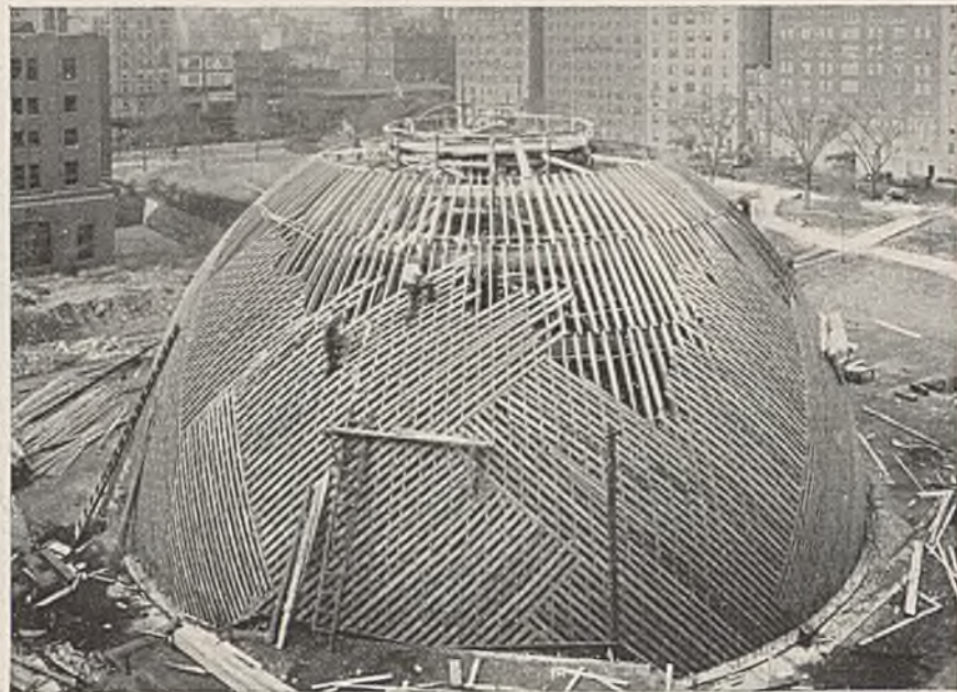
Abb. 14. Rüstung der Kuppel für das Planetarium in New York.
