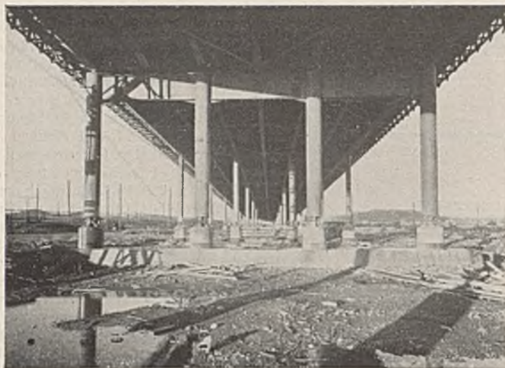
Abb. 44. Querrahmen bei N7 und Nordrampe N7—N14.
