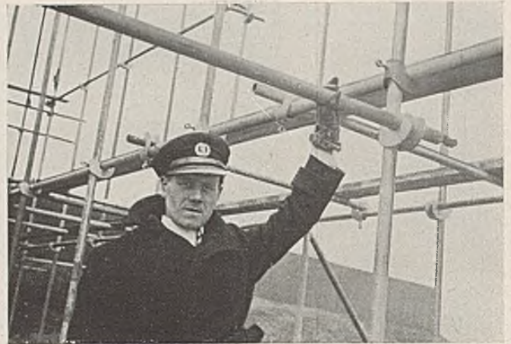
Abb. 35. Flugzeughalle in Doncaster. Einzelheit des Stahlrohrgerüsts.
