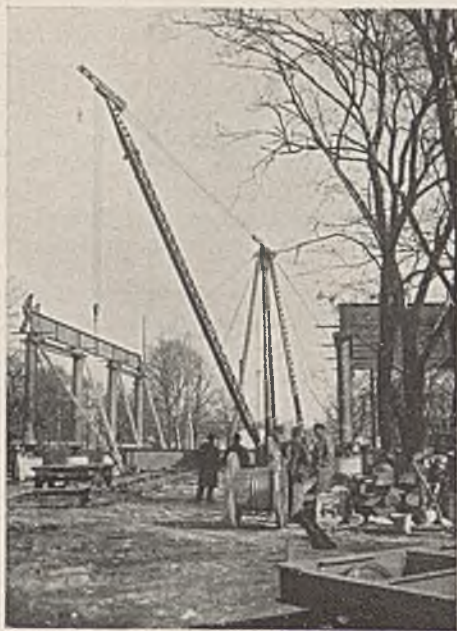
Abb. 47. Aufstellung von Stützen und Querträgern.
