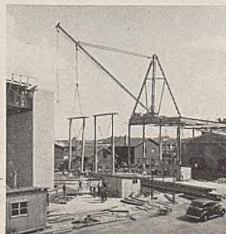
Abb. 46. Rampenmontage mit Vorbauderrick.
