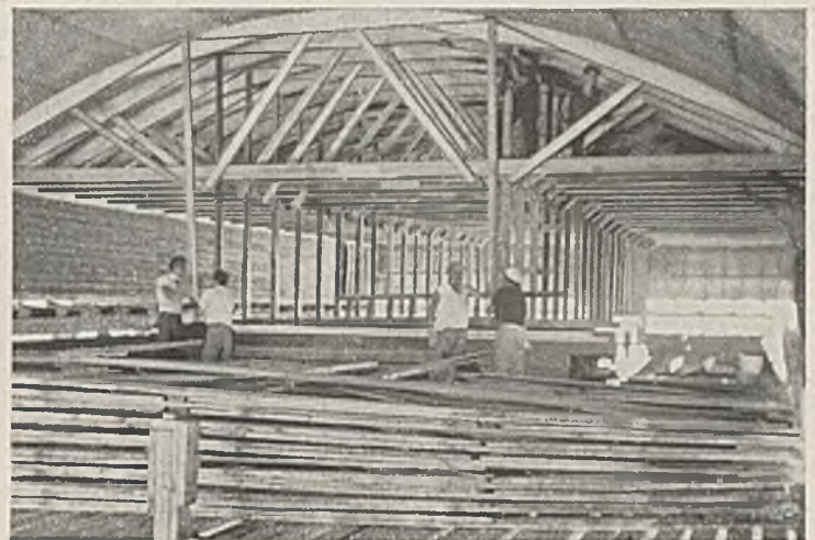
Abb. 11. Klinkerhalle Hudson. Schalung der Gewölbe mit Sperrholzschalung; im Vordergrund Abspindeln der Lehrgerüstbogen.
