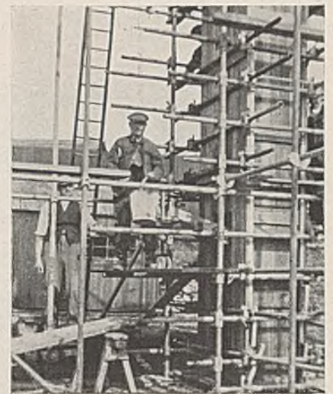
Abb. 36. Flugzeughalle in Doncaster. Schalung einer Hauptsäule.
