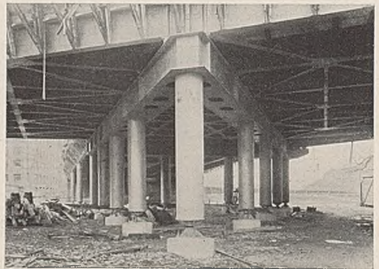
Abb. 42. Ansicht des Stützdreiecks.
