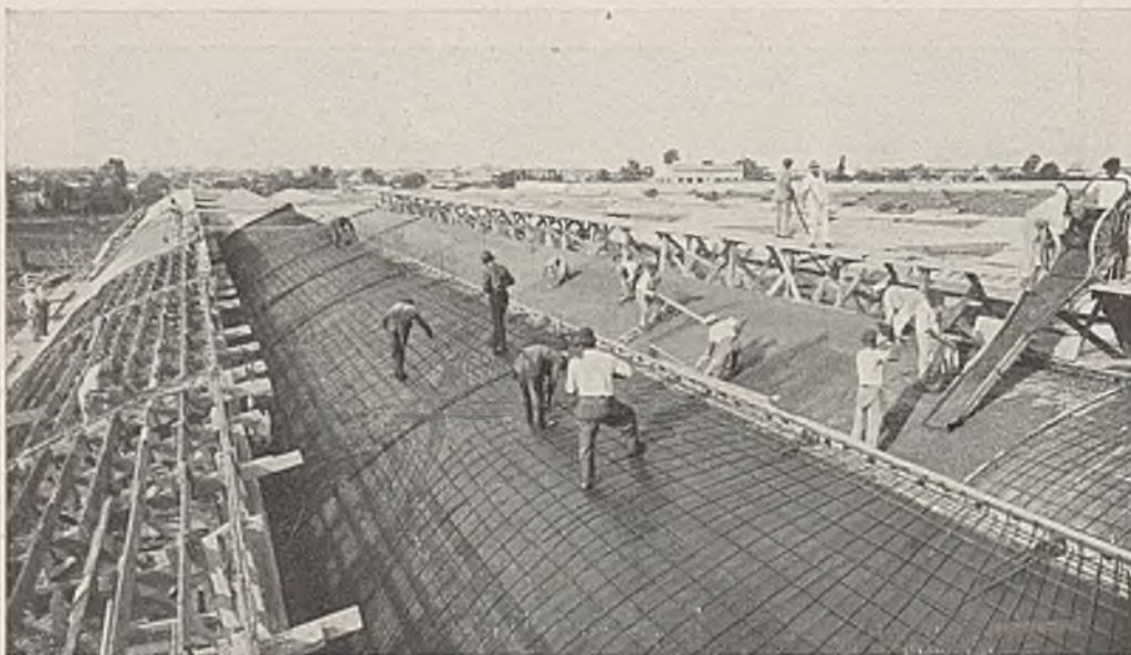
Abb. 17. Textilfabrik Grafa im Bau.
