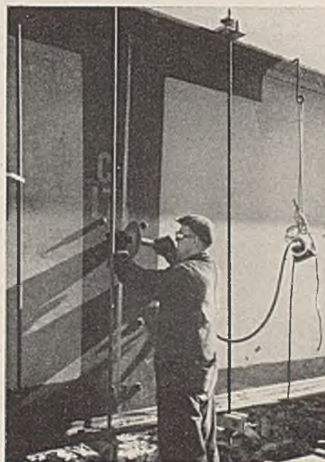
Abb. 19. Nachschleifen der ausgekreuzten Nahtwurzel.
