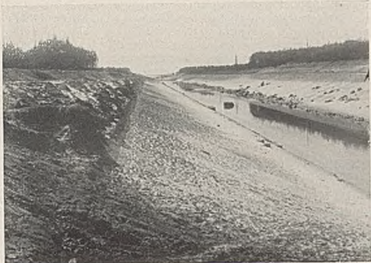
Abb. 78. Seitenkanal Gleesen—Papenburg. Aushub des Kanalbettes bei Meppen durch Trockenbagger.
