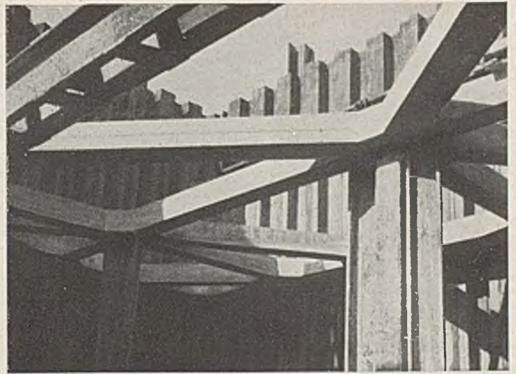
Abb. 68. Baugrube des Stever-Dükers mit Aussteifungen aus Eisenbeton.
