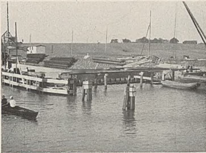
Abb. 67. Bau des Steinacker-Dükers in zwei Teilabschnitten unter Aufrechterhaltung einschiffigen Verkehrs.
