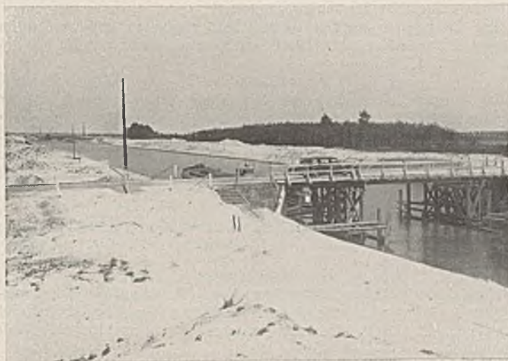
Abb. 79. Seitenkanal Gleesen—Papenburg. Aushub des Kanalbettes in feinem Dünensand durch Naßbagger und Spüler.
