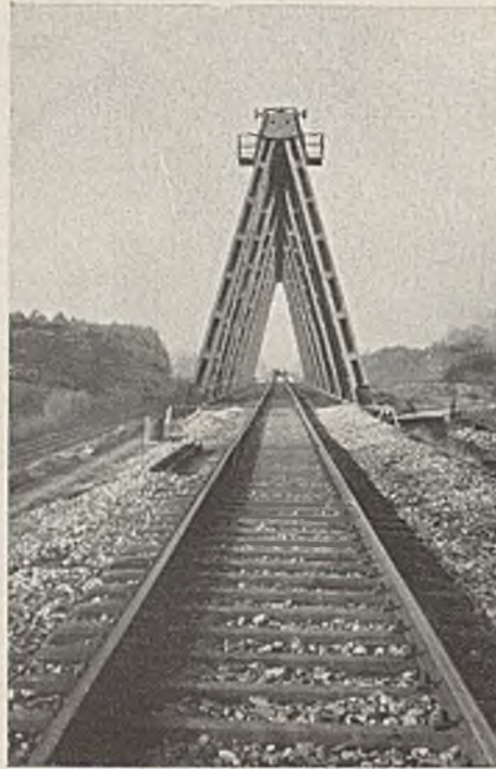
Abb. 74. Eingleisige Reichsbahnbrücke bei der 2. Fahrt Lüdinghausen—Senden.
