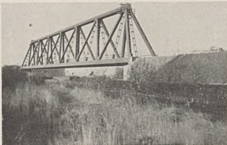
Abb. 75. Eingleisige Reichsbahnbrücke bei der 2. Fahrt Lüdinghausen—Senden.
