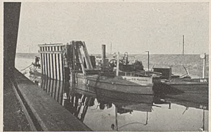
Abb. 76. Umbau der Reichsbahnbrücke bei Hamm am Lippe-Seitenkanal. Einschwimmen eiserner Spundwandtafeln.
