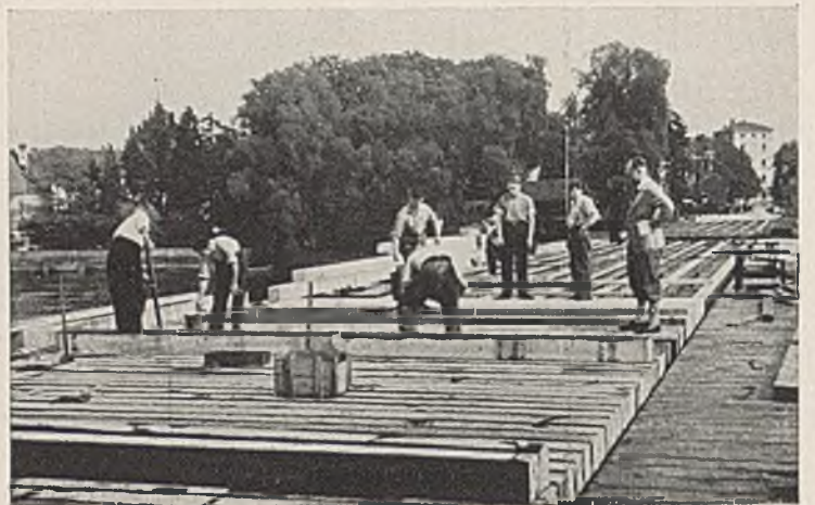
Abb. 18. Einbau der Fahrbahn der Notbrücke.
