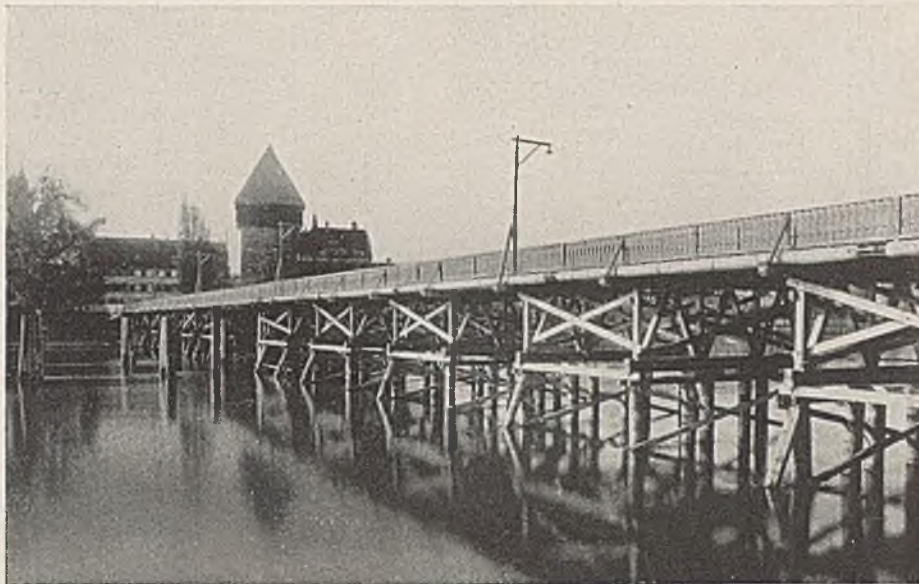
Abb. 20. Ansicht der Notbrücke.
