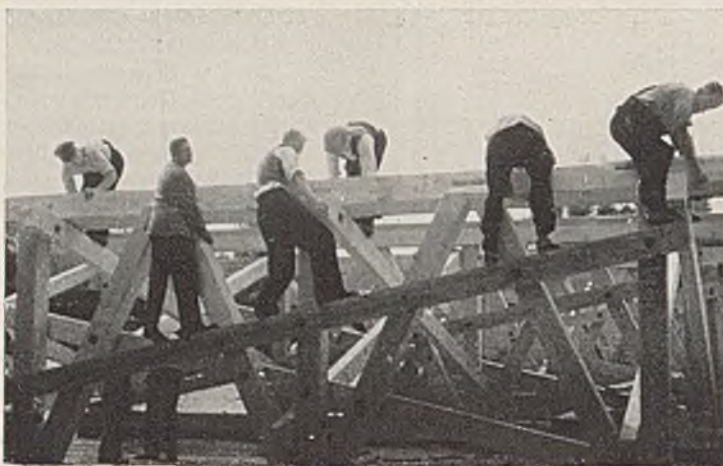
Abb. 17. Abbinden der Strebenböcke der Notbrücke.
