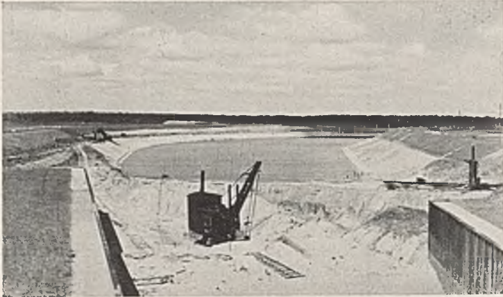
Abb. 6. Baggerarbeiten am Außenhafen Schleuse Niegripp.
