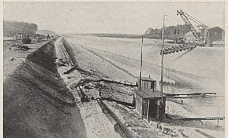
Abb. 5. Trockenbaggerung unter Wasserhaltung.
