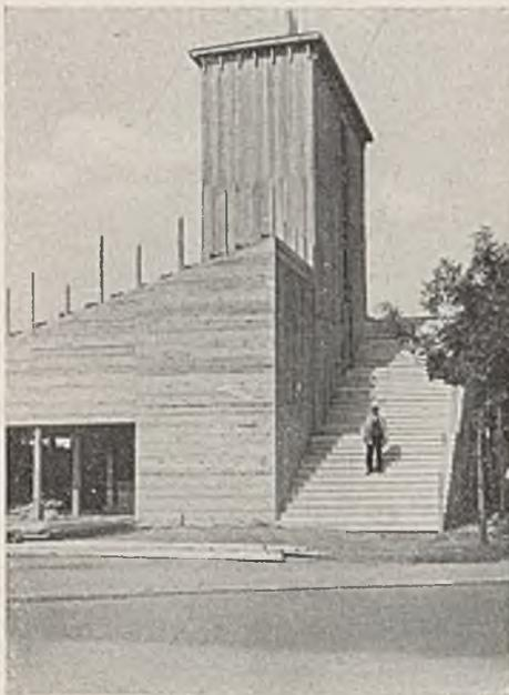
Abb. 18. Fertig verschalter Turm in der Seitenansicht mit Treppe zum Verteilungsgang.
