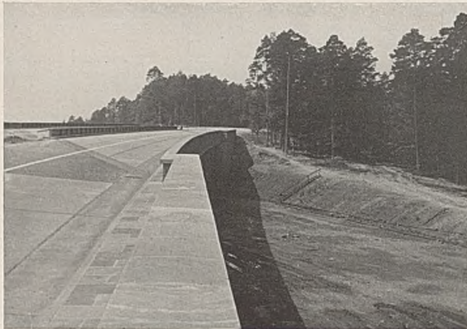
Abb. 28. Blick auf das fertige Bauwerk nach Westen.
