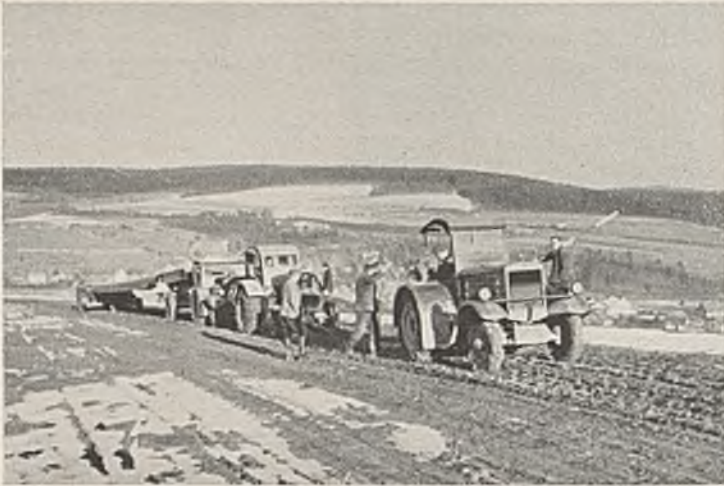
Abb. 25. Beförderung eines Werkstücks auf dem Damm der Autobahn.
