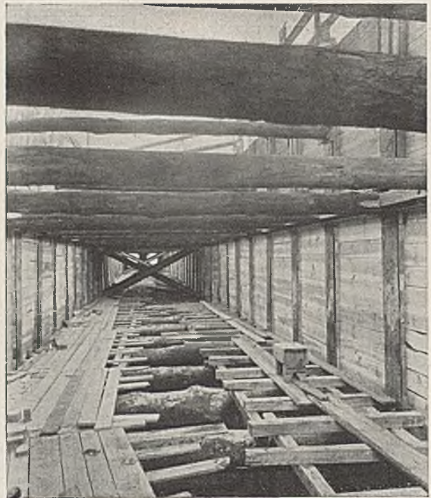
Abb. 3. Aufnahme der Baugrube.
