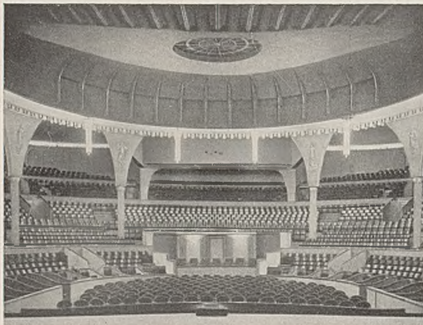
Abb. 2. Neue Decke von Fuß nach Biehle.
