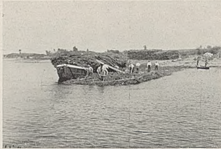
Abb. 5. Vorstrecken des Packwerkskernes einer Buhne.
