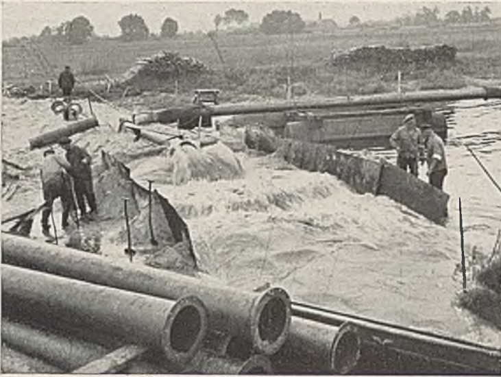
Abb. 8. Einspülen von Sand mittels Druckleitung eines Saugspülbaggers.
