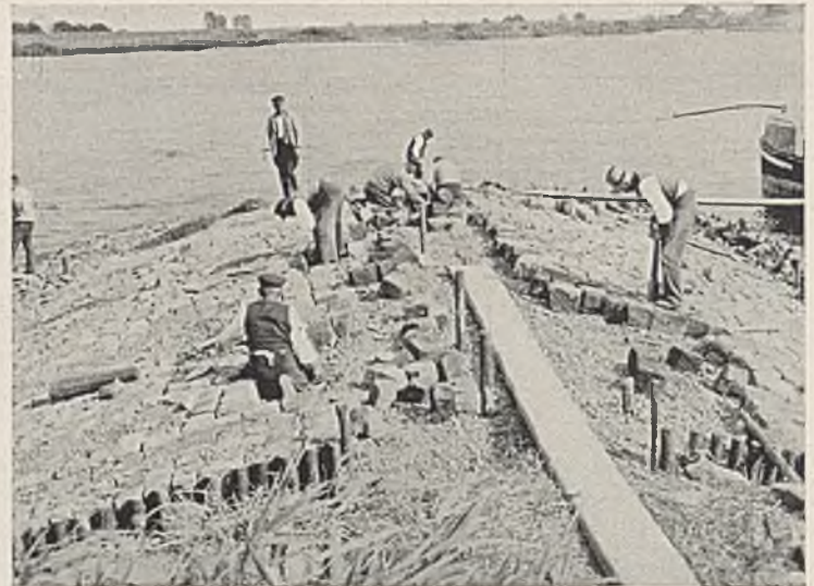
Abb. 7. Abpflasterung eines Buhnenkopfes.
