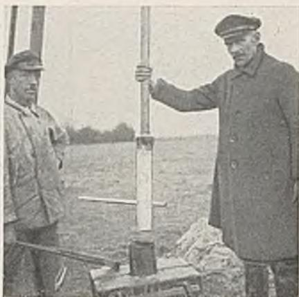
Abb. 6. Einfaches Entnahmegerät (Entnahmestutzen) vor dem Einsetzen.
