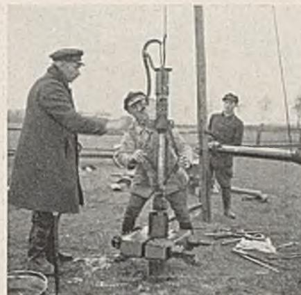
Abb. 8. Festhalten der Bodenprobe mit Saugpumpe.
