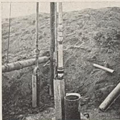
Abb. 10. Verbessertes Hauptgerät mit Ventil im Gestänge.
