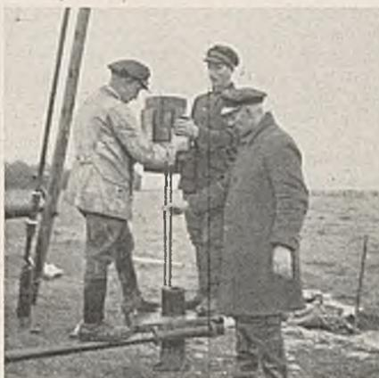
Abb. 7. Einschlagen des Stutzens mit leichtem Rammklotz.
