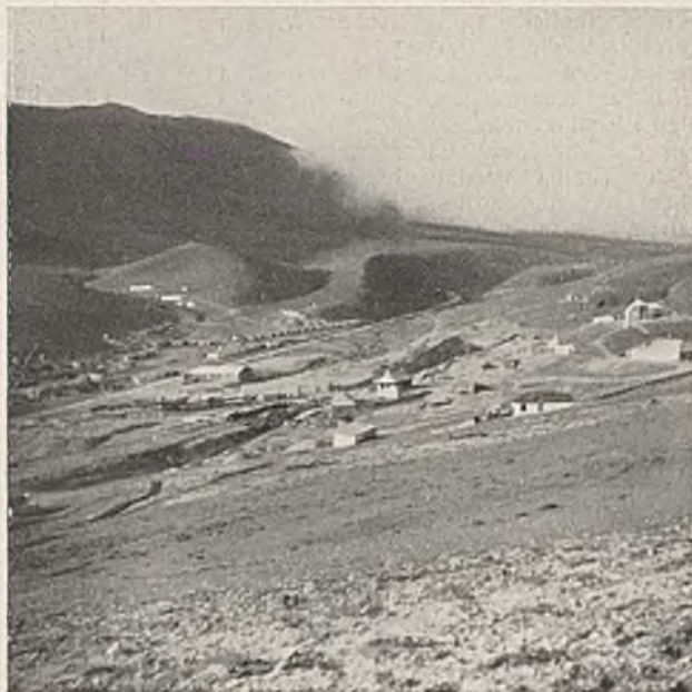
Abb. 1. Ansicht der Südseite des Scheiteltunnels.
