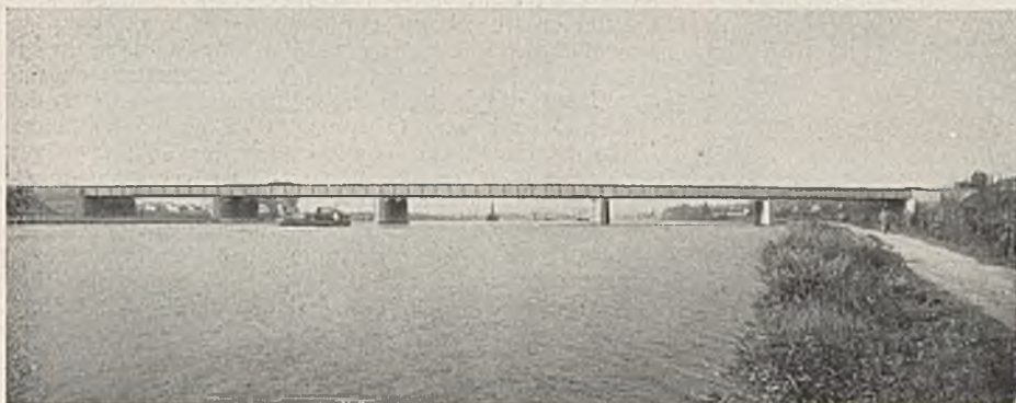
Abb. 1. Flußbrücke mit drei Strom- und zwei Seitenöffnungen und ohne eine einzelne ausgesprochene Hauptöffnung. Der Untergurt der durchlaufenden vollwandigen Träger ist fast waagrecht, der Obergurt ist nach einer flachen Parabel gekrümmt. Die Höhe der Trägerstegbleche beträgt in der Brückenmitte 0,8 m mehr als an den Brückenenden.
