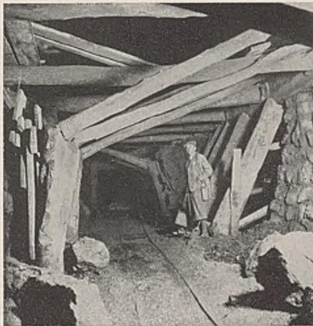
Abb. 7. Widerlagerausbruch und Mauerung.
