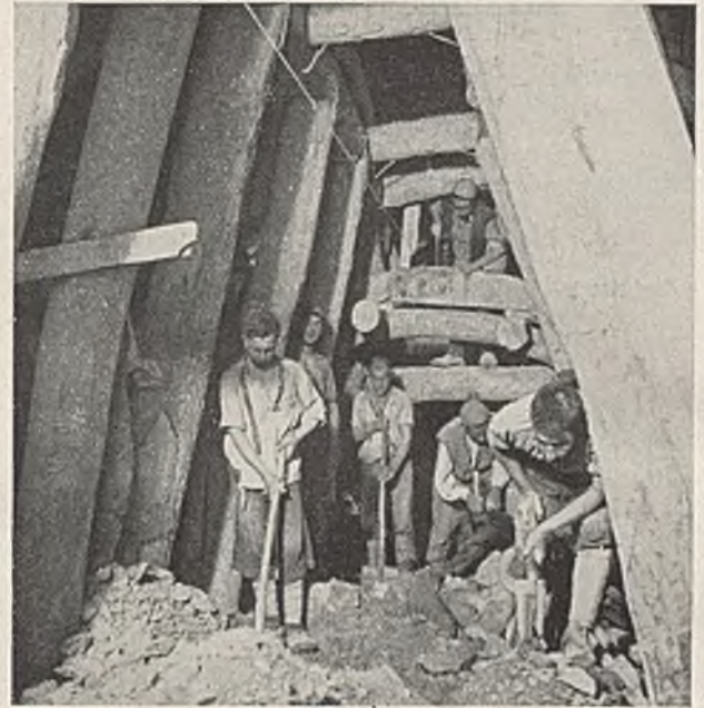
Abb. 6. Kalottenausbruch.
