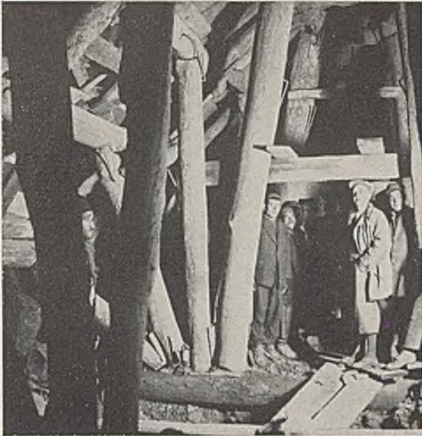
Abb. 5. Kalottenausbruch.
