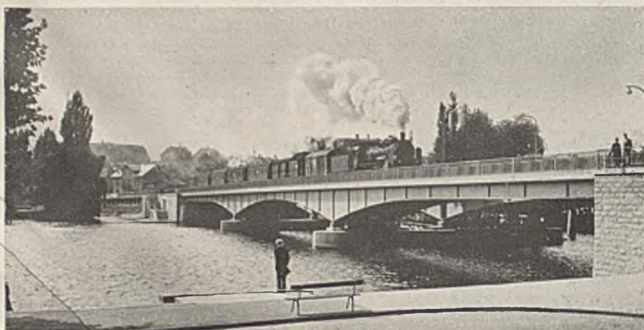
Abb. 7. Brücke über einen Strom mit drei gleich großen Öffnungen. Die vollwandigen Hauptträger liegen unter der Fahrbahn. Der Obergurt ist geradlinig. Der Untergurt in der Mittelöffnung ist ein flacher Kreisbogen, in den Seitenöffnungen im Anschluß an die Strompfeiler je ein Spiegelbild der Hälften der Mittelöffnung und im weiteren Verlauf parallel dem Obergurt. Die mittelste Stromöffnung ist durch die Form des Überbaues gut betont. Die Linie des Untergurtes ist sehr flüssig und lebhaft. Das Brückenbild ist außerordentlich schön.
