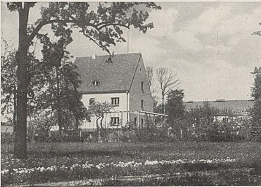
Abb. 22. Dienstwohnung für den Vorstand des Wasserstraßenamts Pillau.
