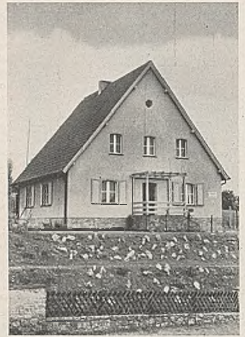
Abb. 23. Dienstwohnung für den Streckenbaubeamten in Frankfurt/Oder.
