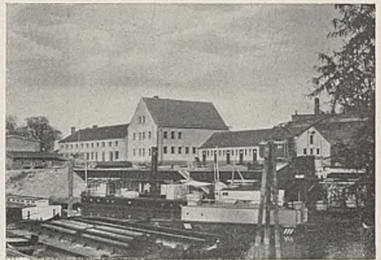
Abb. 21. Kameradschaftshaus und Werkstattengebäude auf dem Bauhof Tilsit. Aufnahme: Rogge.
