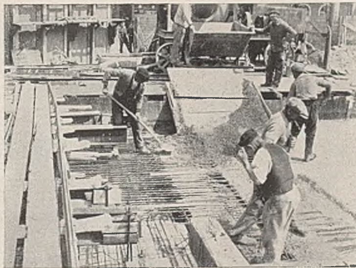
Abb. 9. Betonieren der Decke des Kabelkanals.
