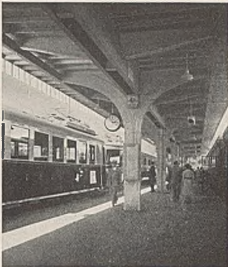
Abb. 9. Ausstellungsbahnhof. Bahnsteigüberdachung in Hetzer-Bauweise.
