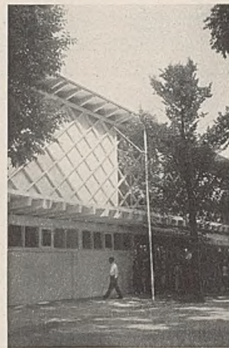
Abb. 3. Außenwand des Obstbau-Pavillons.
