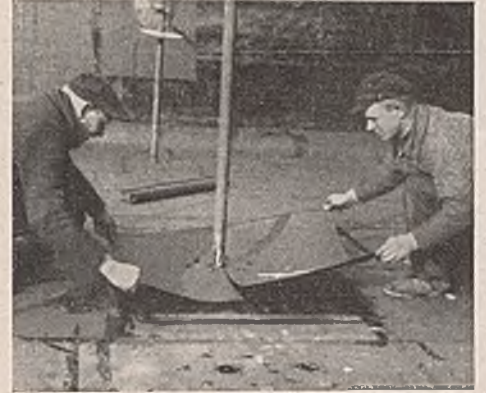
Abb. 6. Dichtungsarbeiten an den Verbindungsankern auf der Senkkastensole.
