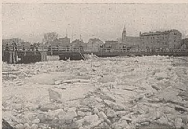
Abb. 13. Gefährdung einer Behelfsbrücke über die Warthe bei Eisgang.
