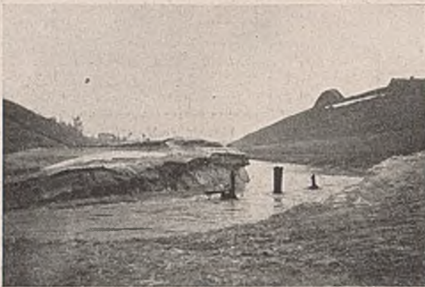
Abb. 9. Durchbruchstrecke bei Gawrony. Warthehochwasser fließt in die Netzeniederung ab.
