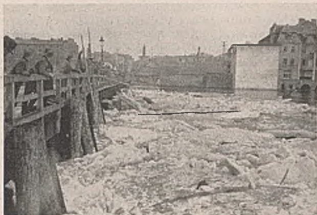
Abb. 14. Gefährdung einer Behelfsbrücke über die Warthe bei Eisgang.
