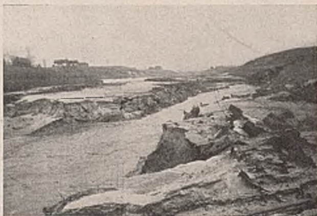
Abb. 10. Durchbruchstrecke bei Gawrony. Warthehochwasser fließt in die Netzeniederung ab.
