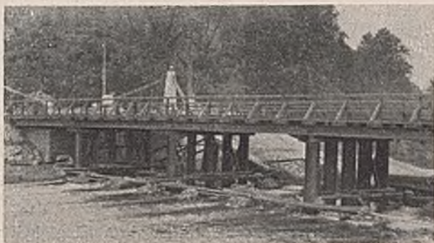
Abb. 25. Walzträgerüberbau auf gerammten Breitflanschträgern.
