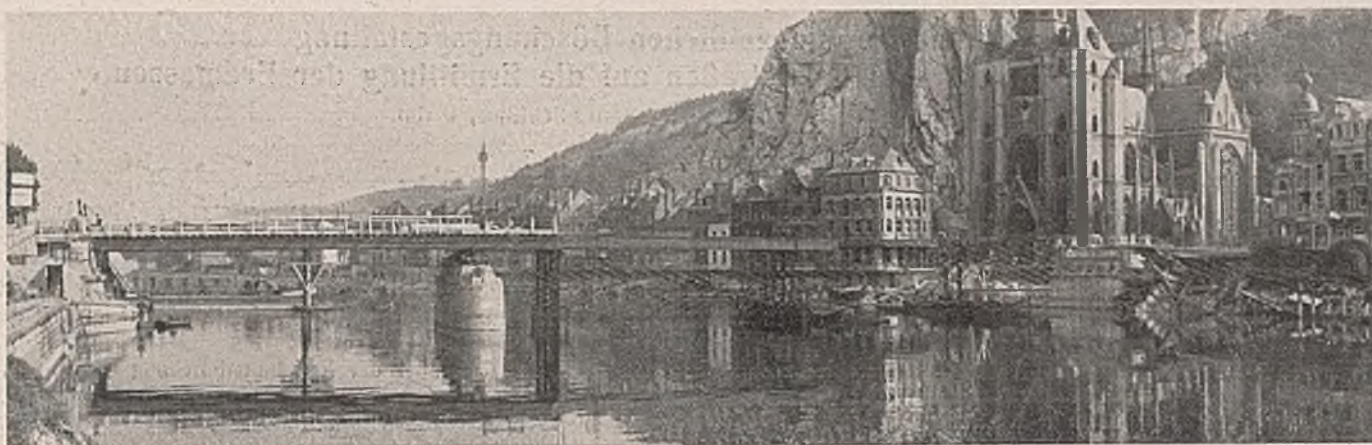
Abb. 23. Blechträger in alter Brückenlage. Zwischen die Trümmer wurden Stahlpfähle gerammt.
