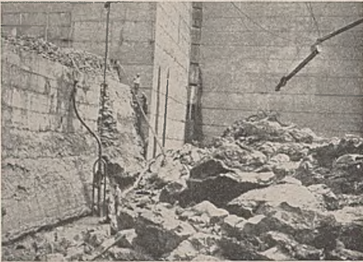
Abb. 9. Felsiger Untergrund zwischen den Senkkästen.
