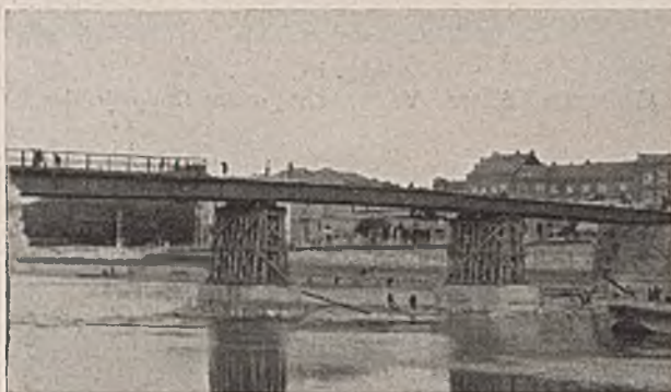
Abb. 21. Blechträger auf Holzjochen, die auf den alten Pfeilerresten der steinernen Brücke stehen. Die Blechträger wurden in einem neu in Betrieb genommenen feindlichen Stahlwerk in 19 Tagen hergestellt.
