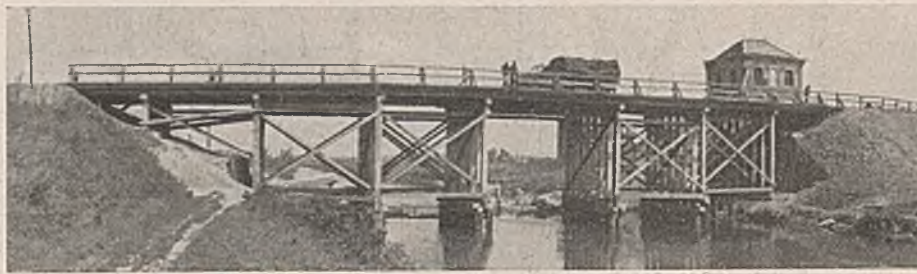
Abb. 5. Walzträgerüberbau neben der zerstörten Brücke. Einfache Holzjoche auf zwei Reihen Ramppfählen.
