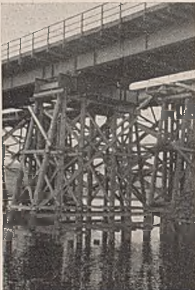
Abb. 6. Blechträgerüberbau in der alten Brückenachse. Die Blechträger wurden neu angefertigt, der eiserne Querriegel der Joche aus der zerstörten Brücke herausgeschnitten. Zweireihige Grund- und Oberjoche.
