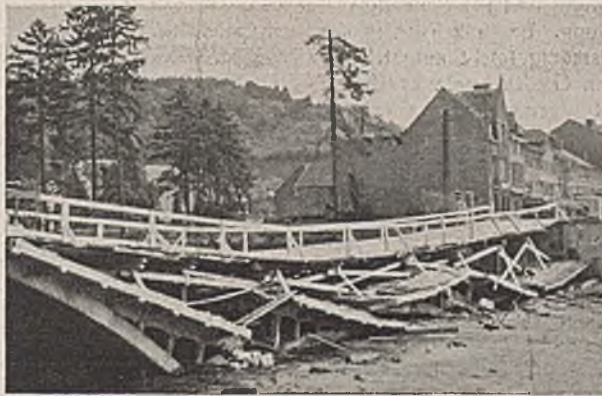
Abb. 1. Die auf den Trümmern der zerstörten Brücke errichtete schnelle Behelfsbrücke ist bereits durchgesackt.
