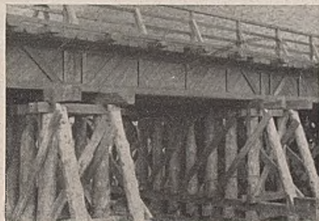
Abb. 15. Genagelte hölzerne Vollwandträger auf Doppeljochen.
