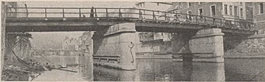
Abb. 13. Walzträgerüberbau auf den erhaltenen Pfeilern und Widerlagern.
