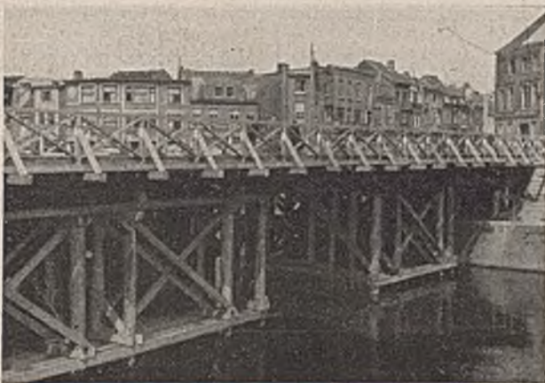
Abb. 3. Walzträgerüberbau neben der zerstörten Brücke, unmittelbar auf den 16 m langen Rammpfählen aufgesetzt.
