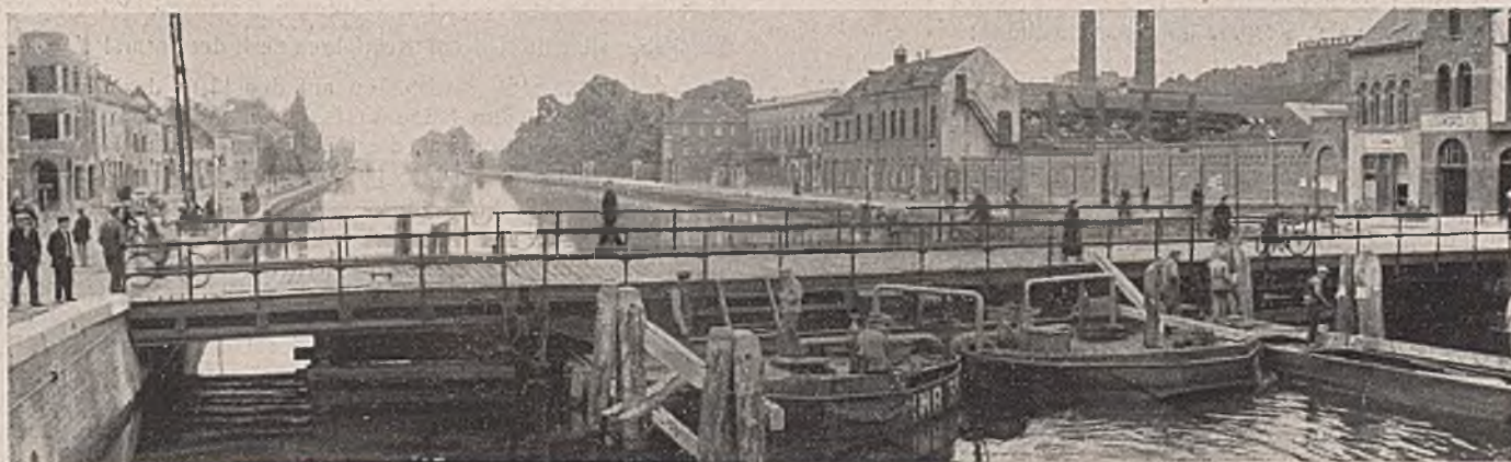
Abb. 27. Dauerbehelfsbrücke mit ausschwimbarem Mittelteil.
