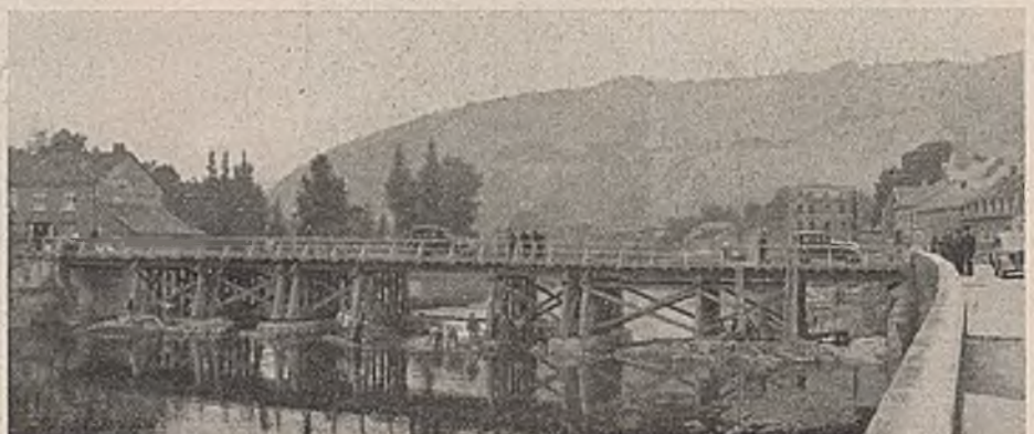
Abb. 10. Walzträgerüberbau auf Holzjochen, die auf gemauerten Grundkörpern stehen. Bauzeit 5 Tage.
