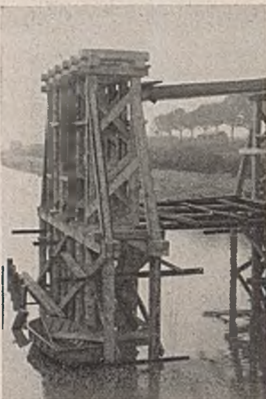
Abb. 7. Zweireihiges Grund- und Oberjoch.
