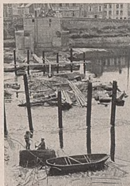
Abb. 26. Zwischen den Trümmern der zerstörten Brücke gerammte Pfähle aus Breitflanschträgern.
