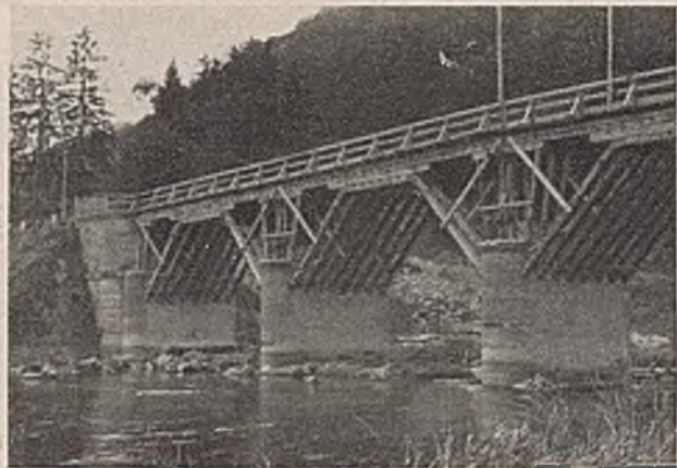
Abb. 17. Trapezsprengwerk mit verdübelten Balken auf den erhaltenen Pfeilern der zerstörten Brücke. Etwa 15 m Pfeilerentfernung.
