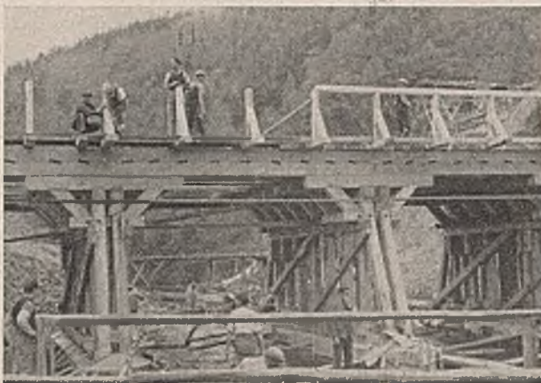
Abb. 14. Dauerbehelfsbrücke in der alten Brückenachse mit verdübelten Balken, Sattelholz und Kopfbügen.
