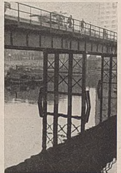
Abb. 22. Dauerbehelfsbrücke in einer großen Stadt. Die Brücke wurde in neuer Lage errichtet. Blechträgerüberbau auf Stahljochen aus Spundwandisen.
