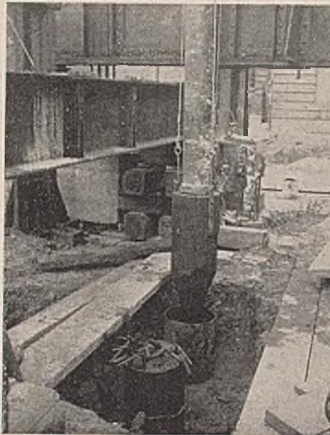
Abb. 4. Anordnung der Probelastung der Spitze eines Blechrohrpfahles.
