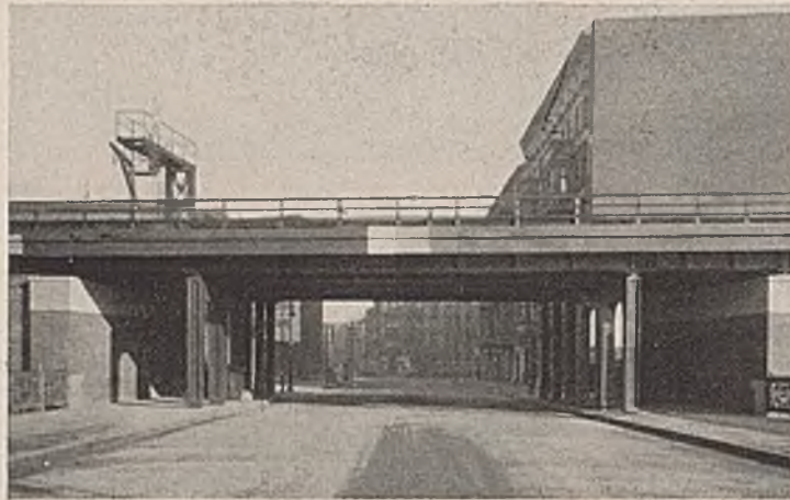
Abb. 14. Eisenbahnbrücke über eine städtische Straße.
