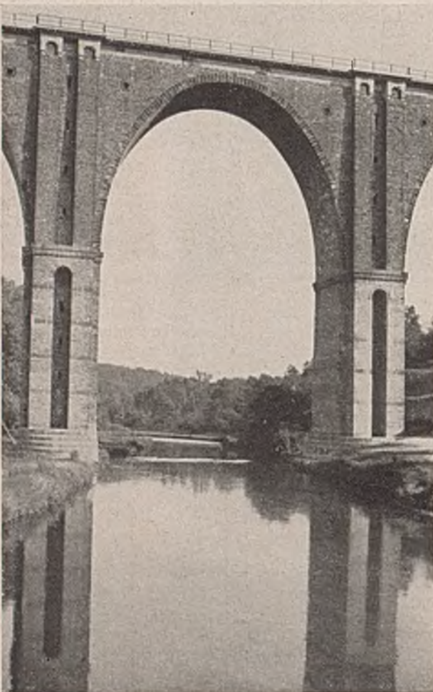
Abb. 30. Flußöffnung der Brücke in Abb. 29.
