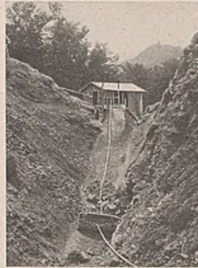
Abb. 8. Schrapper beim Herstellen eines Einschnitts (Demag).
