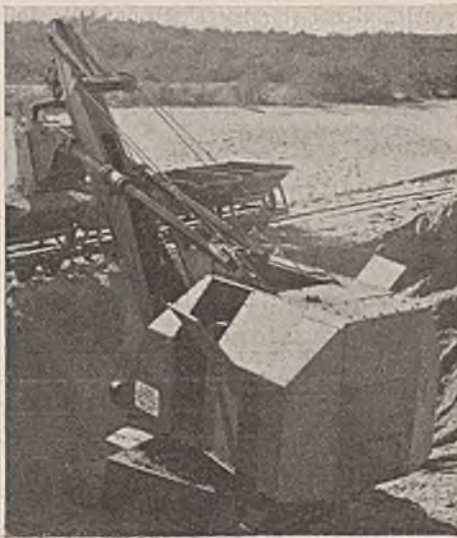
Abb. 1. Hochlöffelbagger mit doppeltem Löffelstiel (MBA).
