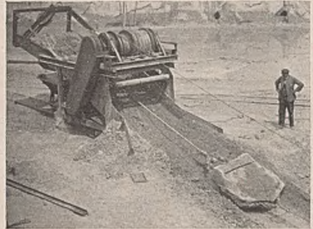
Abb. 9. Entladeschräge mit aufgebautem Windwerk eines Schrappers (Ibag).
