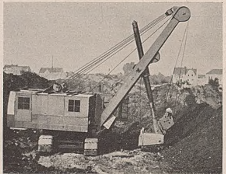
Abb. 4. Hochlöffelbagger E 31 mit Hochlöffleinrichtung II B (Demag).
