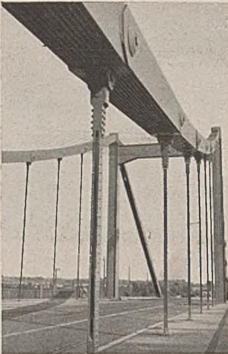
Abb. 83. Hänger aus Flachstäben an einer Kettenbrücke.
