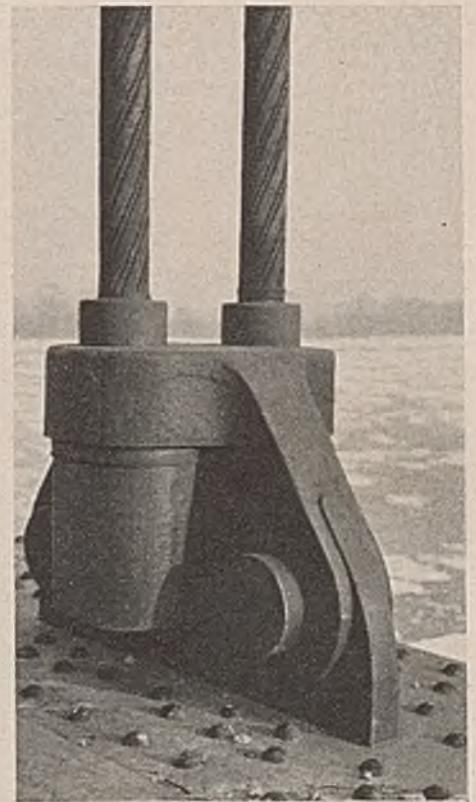
Abb. 97. Aufhängung am Versteifungsträger mit über dem Gurt liegendem Hängekörper aus Stahlguß, zweifaches Hängeseil.
