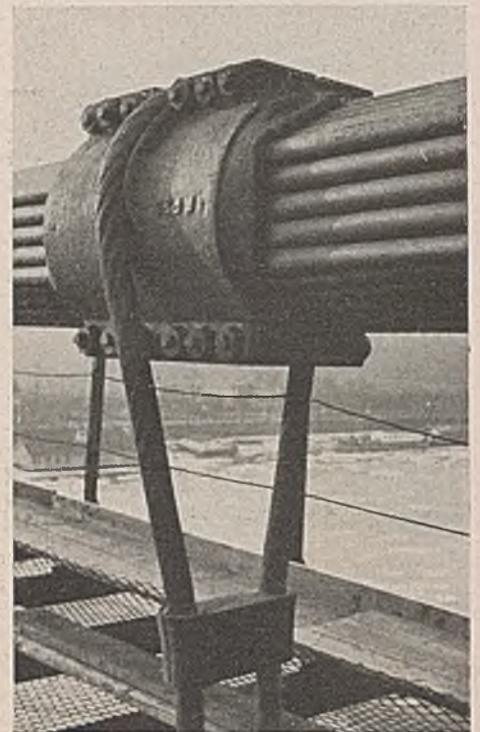
Abb. 85. Über die Kabelschelle gelegte zweifache Hängeselle.
