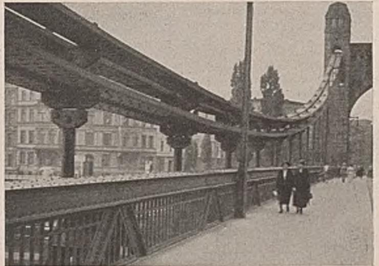
Abb. 72. Tragband aus flachliegenden Breitflachstählen.
