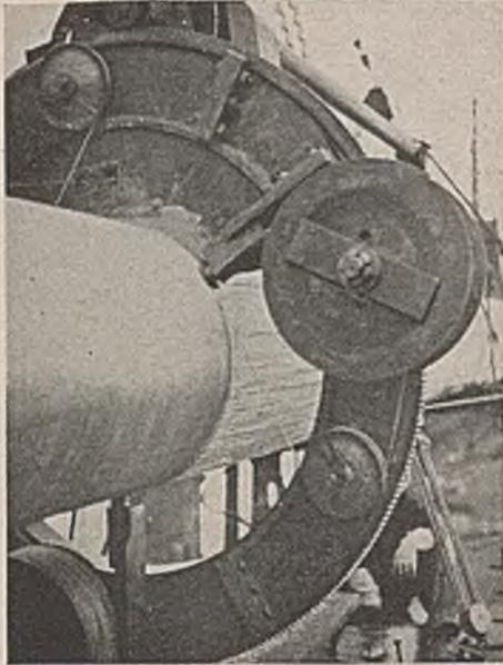
Abb. 79. Umwicklung eines luftgesponnenen Paralleldrahtkabels mit weichgeglühtem Draht (Vorschlag Leonhardt).
