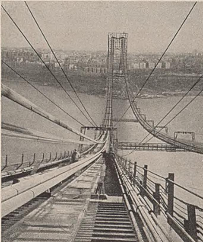
Abb. 76. Runde Paralleldrahtlitzen beim Luftspinnverfahren. George Washington-Brücke, New York.
