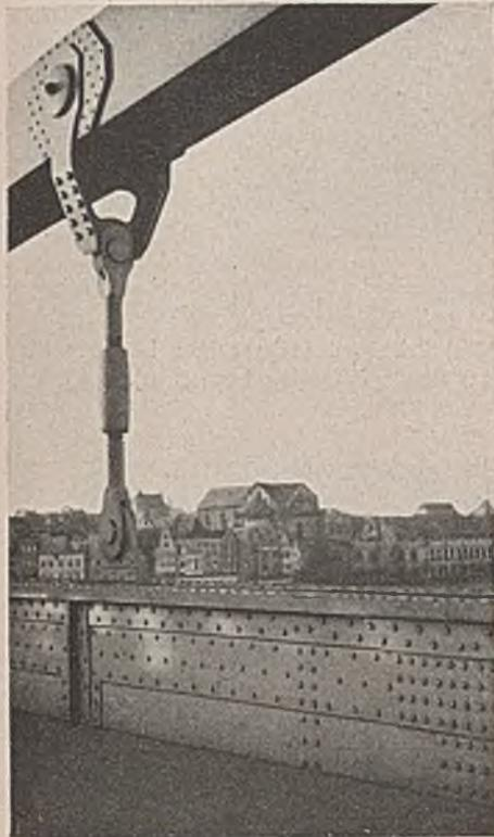
Bei den Tragbändern aus flachliegenden Breitflachstählen oder Blechen mit vernieteten Stößen, die in mehreren Lagen übereinander angeordnet werden (Abb. 72), ist der Anschluß der Hänger schwieriger. Bolzengelenkketten sehen auch besser aus.
