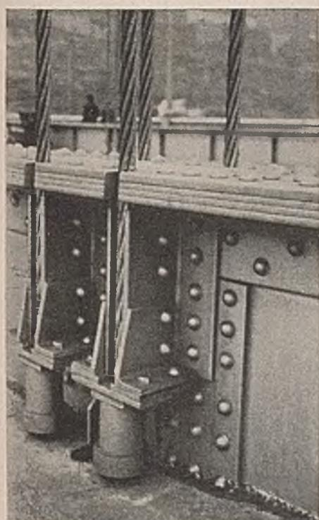
Abb. 96. Aufhängung am Versteifungsträger über der Fahrbahn mit vierfachen Hängeseilen, Einzelheiten nicht vorbildlich.
