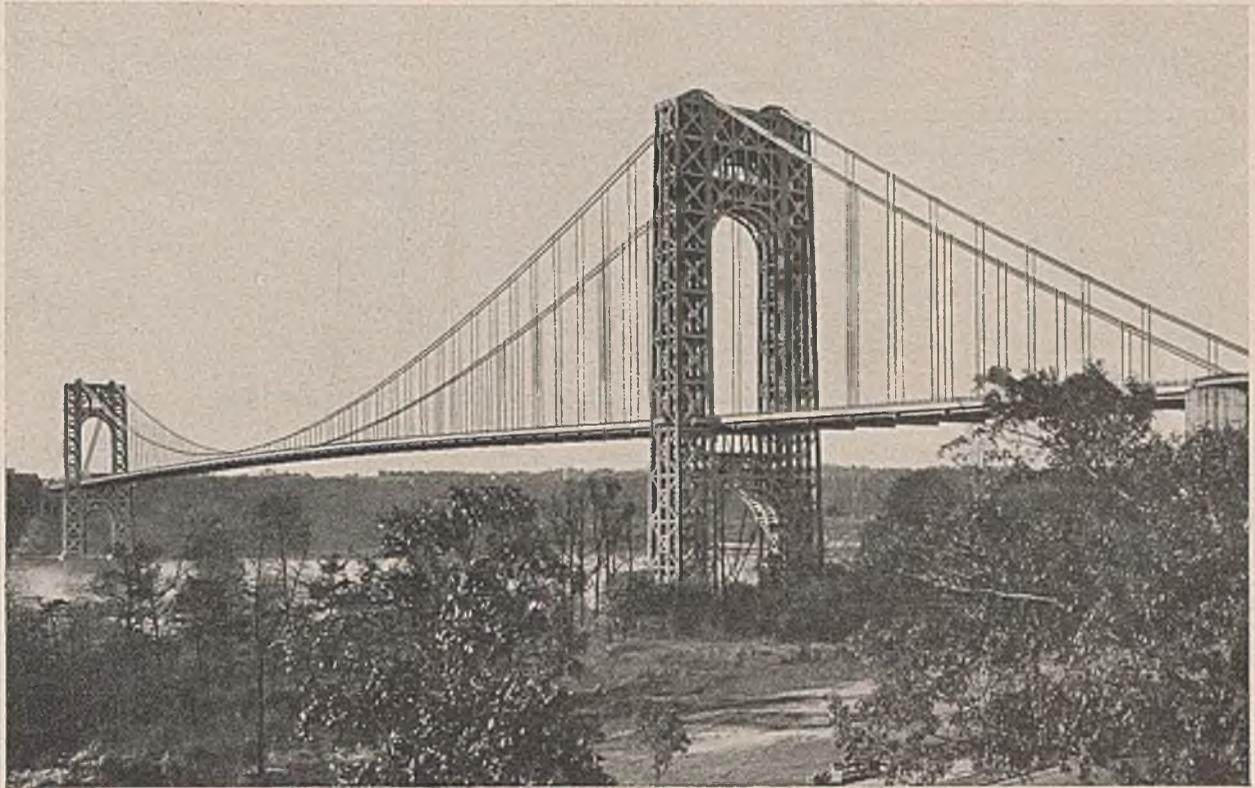
Abb. 95. Die sichtbare Querträgeraufhängung ergibt eine natürliche Gliederung des Fahrbahnbandes (George Washington-Brücke, New York).
