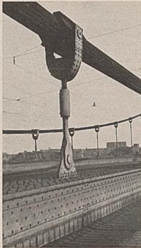
Abb. 84. Sechseckige Kabelschellen mit Gelenkkorb für den Hängeranschluß.
