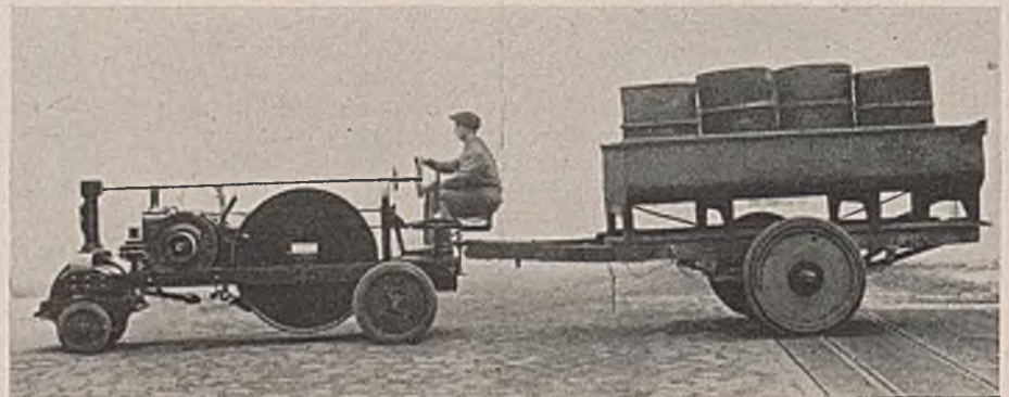
Abb. 19. Motorwalze mit Straßenfahrwerk (Kemna).
