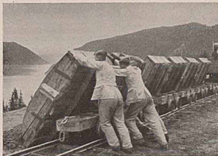
Abb. 3. Erdarbeiten für einen Bahnbau in Norwegen.
