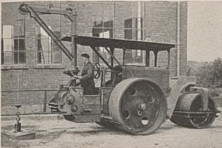
Abb. 21. Dreirad-Motorwalze mit Stampfeinrichtung (Scheid).
