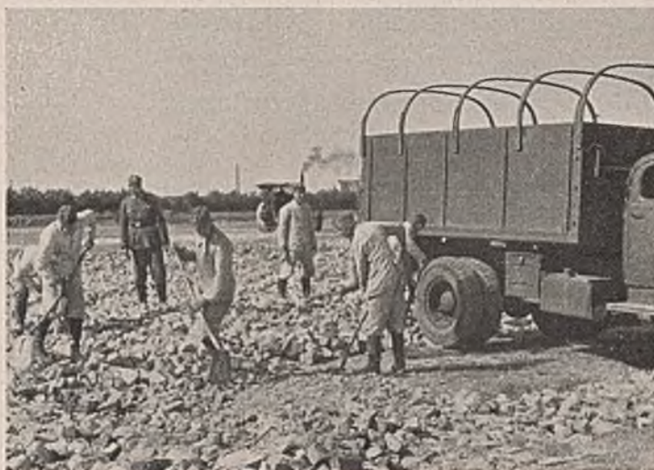
Abb. 1. Packlagearbeiten für eine Abflugbahn.
