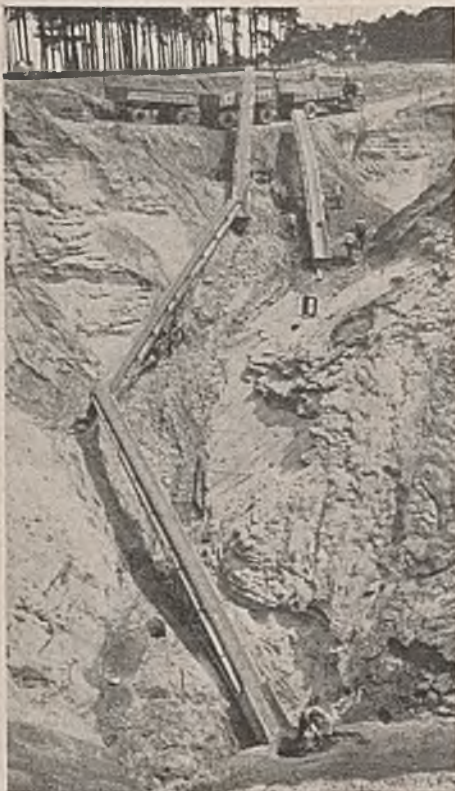
Abb. 14. Fahrbare Förderbänder in schwierigem Gelände (Bleichert).
