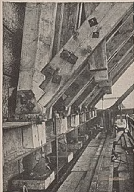
Abb. 14. Auflager der hölzernen Binder. Im Hintergrunde Fahrgestell des Hilfsgerüsts.
