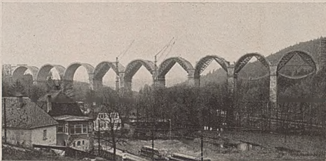
Abb. 19. Ansicht der Brücke während der Staffelwölbung.
