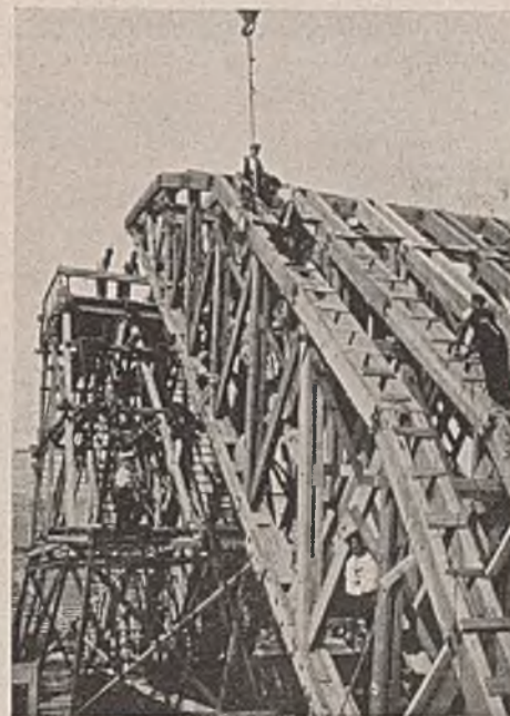
Abb. 16. Aufsetzen eines hölzernen Binderteiles des Lehrgerüsts auf das Hilfsgerüst.
