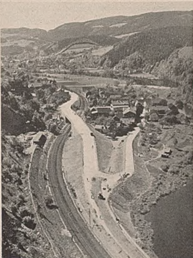
Abb. 1. Bauwerk I, Gesamtbild.
