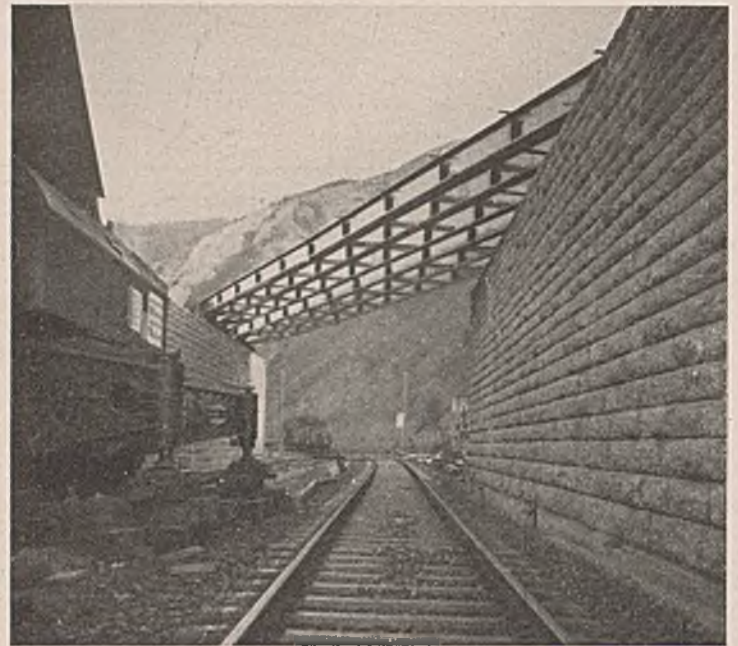
Abb. 11. Bauwerk I, das Stahlträgernetz ist fertig zusammgebaut.
