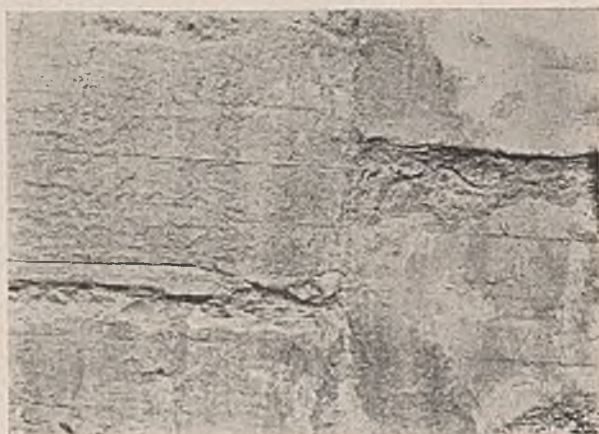
Abb. 9. Verwitterter Beton.
