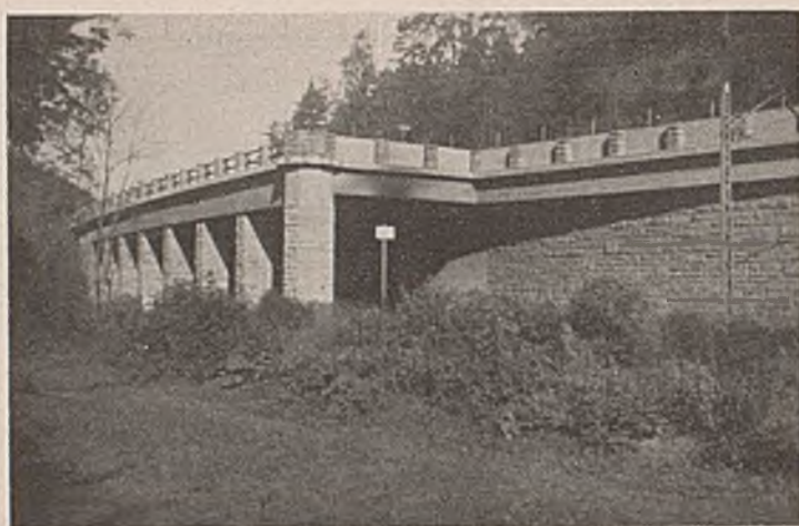
Abb. 21. Bauwerk III, Südende, Säulen und Stützwand.
