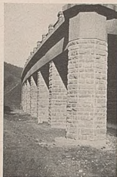
Abb. 20. Bauwerk III, Säulen.
