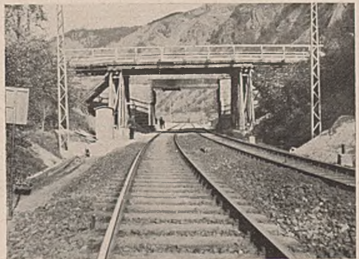
Abb. 3. Bauwerk I, Notbrücke, dahinter die alte Brücke.
