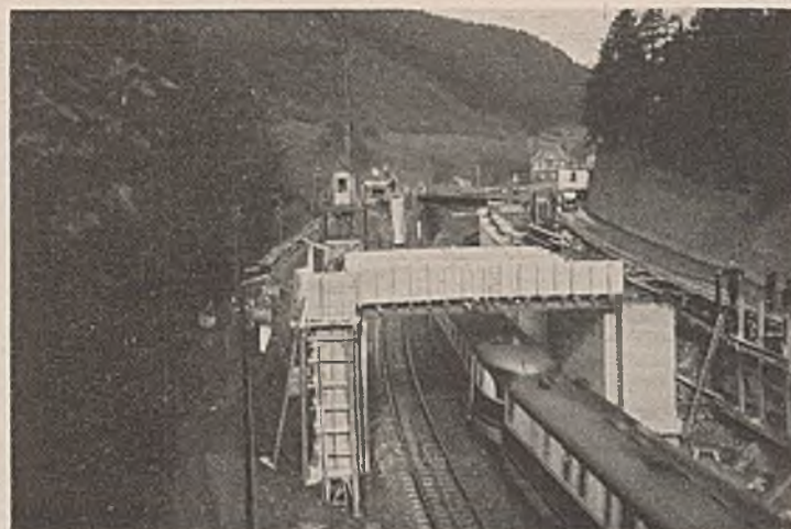
Abb. 22. Bauwerk III, Bauausführung, im Hintergrund die alte Brücke.
