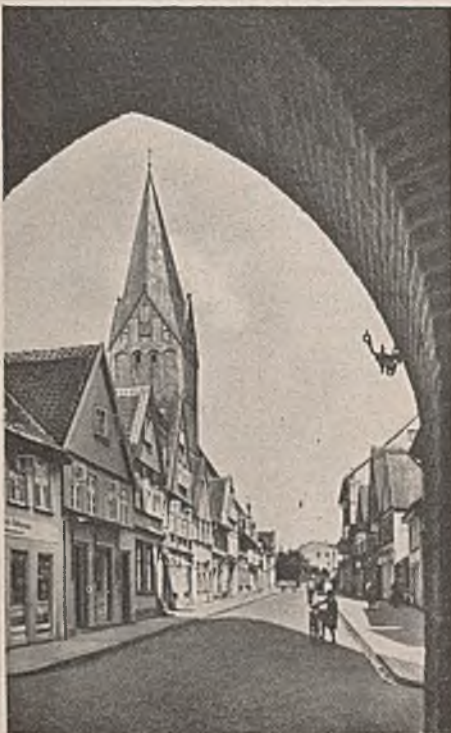
Abb. 19. Straßenansicht in C.
