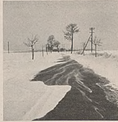
Abb. 4. Schneeverwehung an der vom Schneepfluge geschaffenen Wand.
