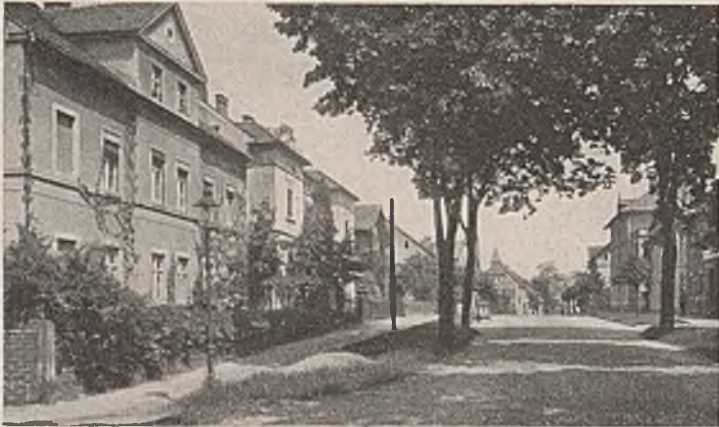
Abb. 23. Ortsdurchfahrt in D.
