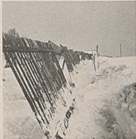
Abb. 6. Hochziehen eines vollgewehten Schneezäunes.
