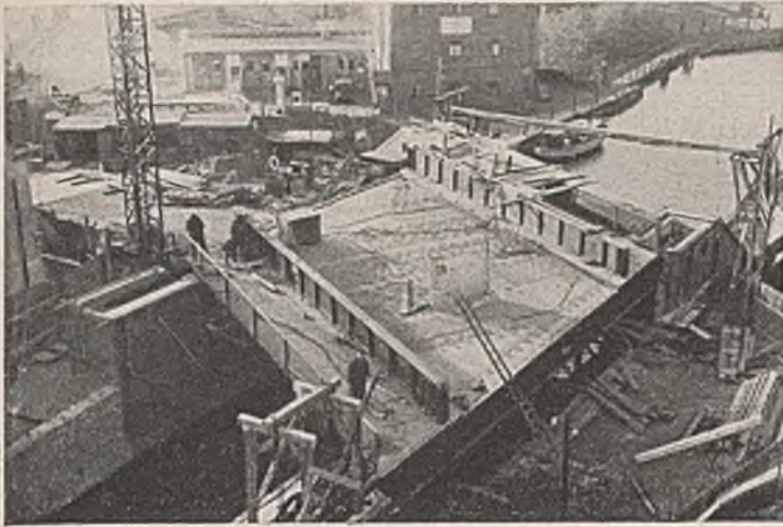
Abb. 6. Aufschweißen des Baustahlgerüsts.
