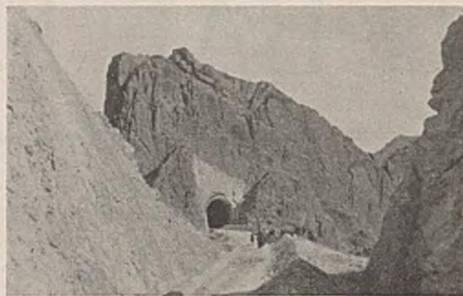
Abb. 7. Tunnel mit Voreinschnitt.
