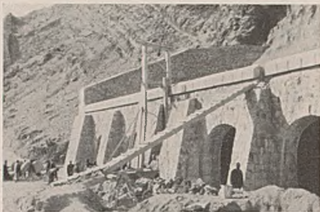
Abb. 6. Bau der Galerie.
