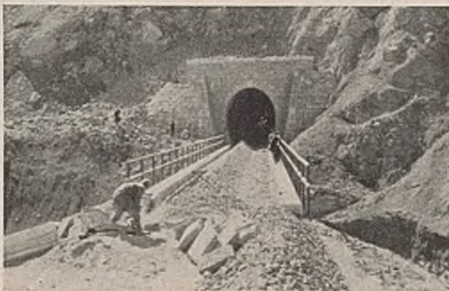
Abb. 4. Eisenbetonbrücke und Tunnelleingang.
