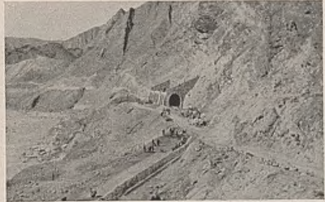
Abb. 3. Strecke am Steilhang mit Schutzgalerie.
