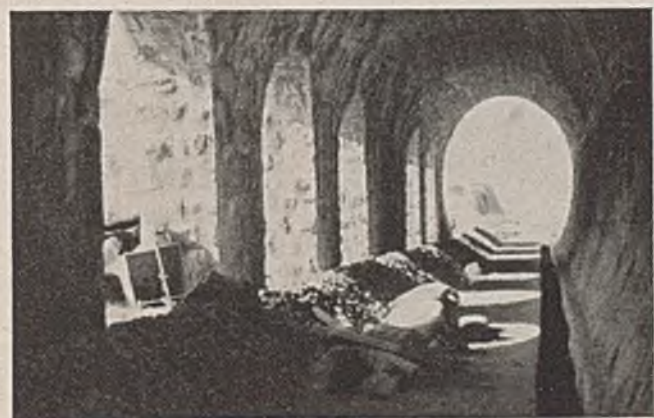
Abb. 5. Schutzgalerie am Abbruchhang.
