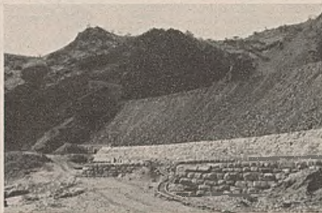
Abb. 10. Sicherung des Fußes eines 15 m hohen Dammes.
