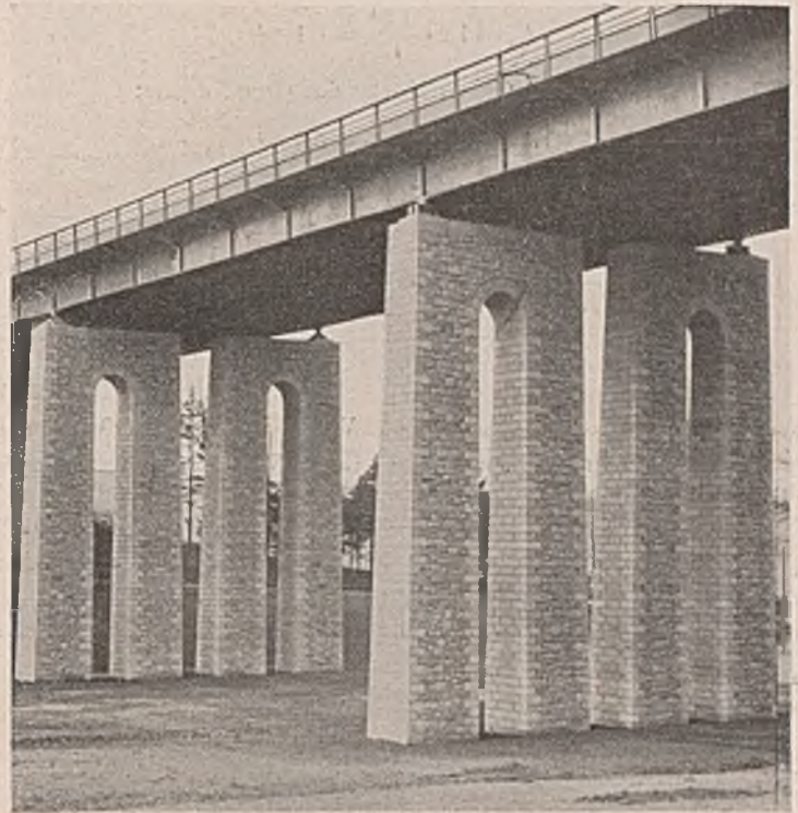
Abb. 18. Talbrücke mit geteilten und aufgelösten Pfeilern.
