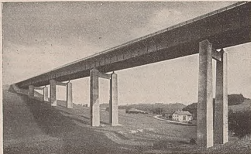
Abb. 14. Talbrücke mit aufgelösten, rahmenartigen Eisenbetonpfeilern.
