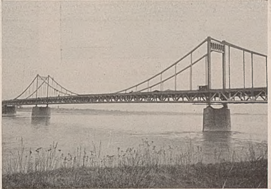
Abb. 2. Brücke mit zu kleinen Pfeilern.
