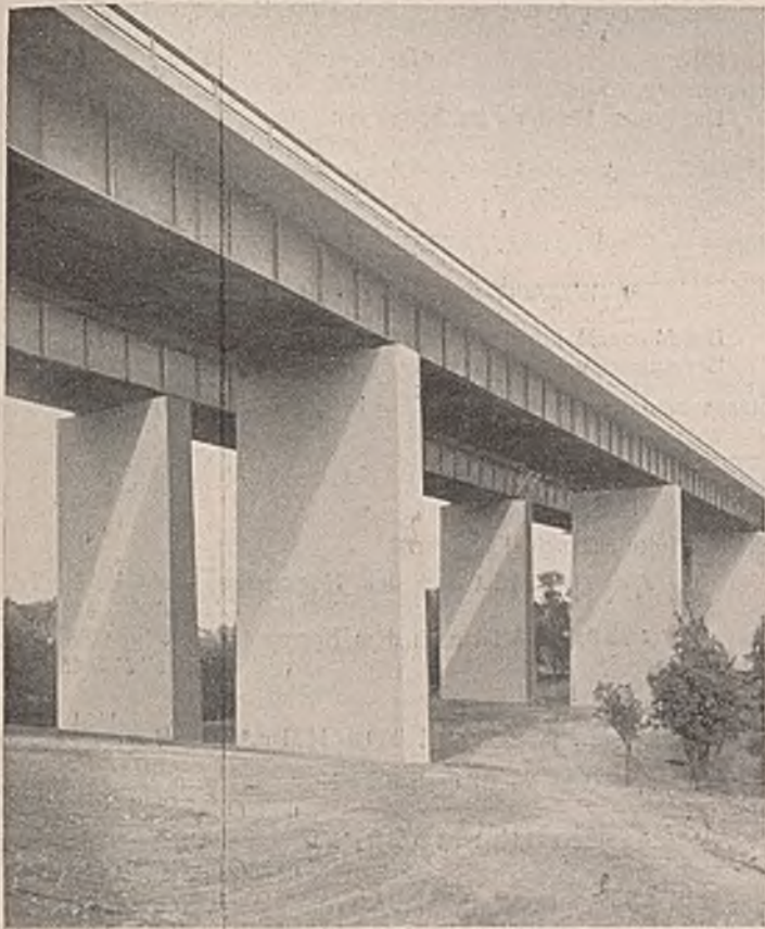
Abb. 17. Talbrücke mit geteilten Pfeilern.
