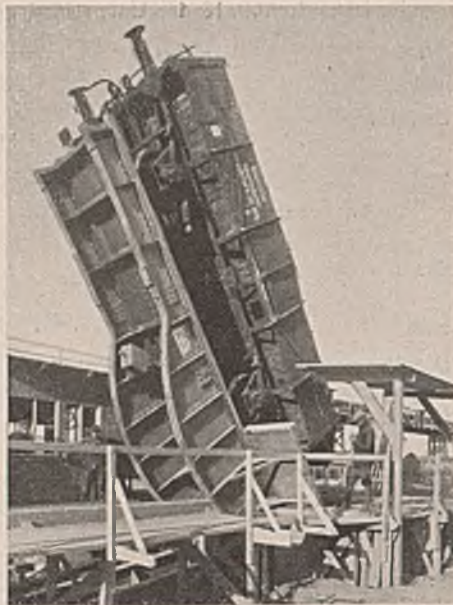
Abb. 3. Wagenkipper auf einer Baustelle der Reichsautobahn bei Frankfurt a. d. Oder. Aufn. (2): Maschinenfabrik Augsburg-Nürnberg AG.
