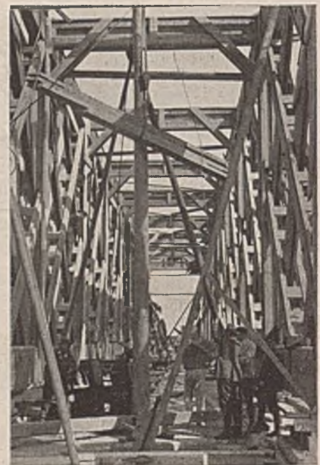
Abb. 35. Zusammenbau der 50-m-Brücke auf der Fahrbahn der vollwandigen Träger.
