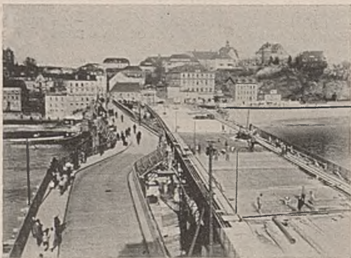
Abb. 27. Abdichtung einer Strombrücke mit 0,2 mm dicken Kupferbronzebahnen.
