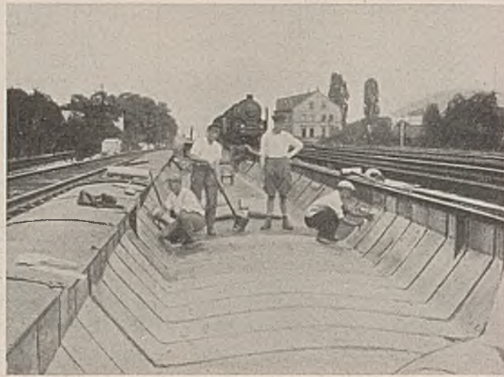
Abb. 28. Verlegen einer Blechbanddichtung in einem eisernen Brückentrog.
