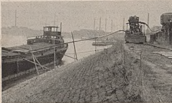
Abb. 3. Fahrbare Luftförderanlage im Betrieb.
