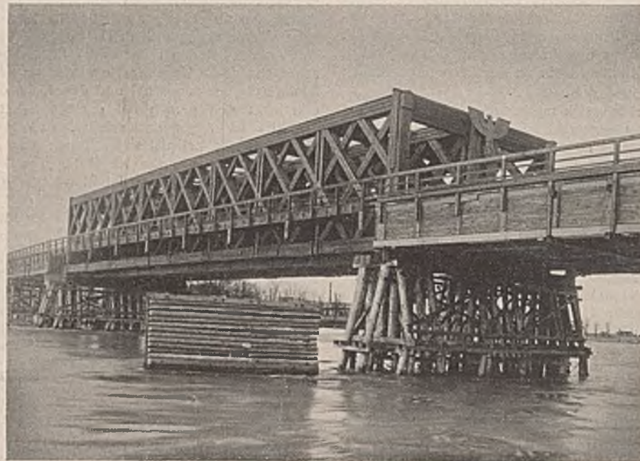
Abb. 3. Teilansicht der genagelten, hölzernen Straßenbrücke für schwersten Verkehr — Schiffsfahrtsöffnung.
