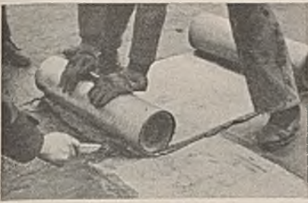
Abb. 10. Einwalzen von dünnem, geriffeltem Blechband in die breifige, heiße, vor die Metallrolle gegossene Sonderbitumenmasse. Die Masse verteilt sich einheitlich und quillt seitlich an den Rändern hervor.
