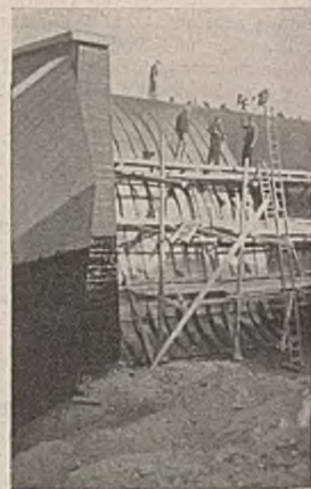
Abb. 29. Abdichten eines Gewölbedurchlasses mit Blechbändern. Die Blechbänder werden von unten nach oben in einem Stück bis über Scheitelmittle aufgeklebt.
