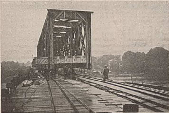
Abb. 36a. Die 50-m-Fachwerkbrücke auf der Fahrt über die Vollwandträgerbrücke.
