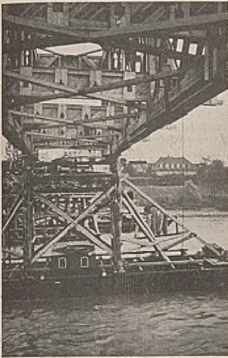
Abb. 36b. Die 50-m-Fachwerkbrücke mit ihrem auskragenden Ende abgestützt auf dem Kahn während der Vorfahrt.
