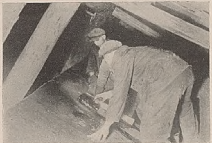
b) Kleben des Bandes gleichgerichtet zur Tunnelachse.
