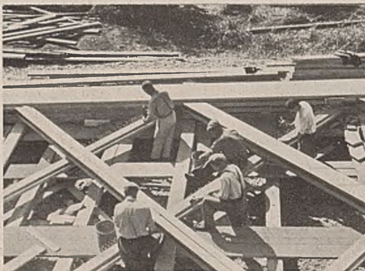
Abb. 32. Nagelung an der liegenden Fachwerkwand.
