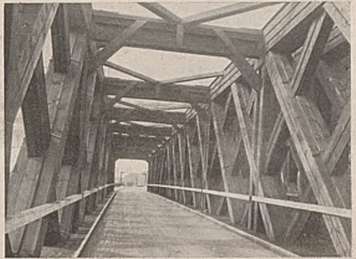
Abb. 39. Die Verschalung der einzelnen Fachwerkteile und der obere Wind- und Knickverband.
