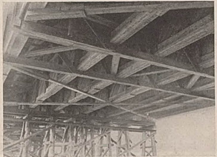
Abb. 8. Untersicht unter die 20-m-Vollwandüberbauten. Unterer Windverband und Querverbände.
