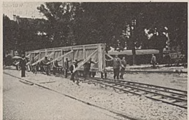
Abb. 29. Heranfahren eines Vollwandträgers.
