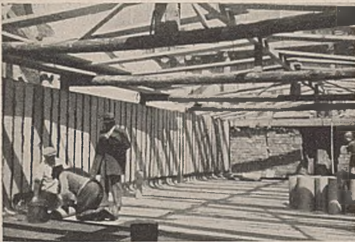
Abb. 39. Ausführung einer Trogdichtung mit geriffelten 0,2 mm dicken Alcuta-Dichtungsbahnen.
