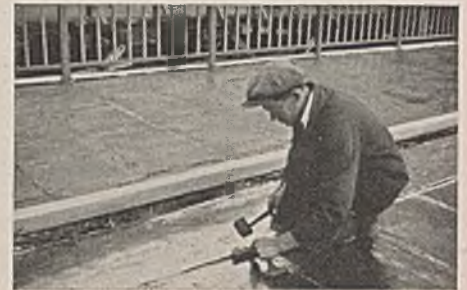
Abb. 21. Ausführung der Falznaht einer 0,3 mm dicken Blechbanddichtung.
