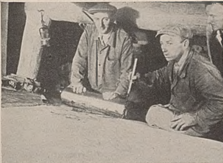
a) Kleben des Bandes senkrecht zur Tunnelachse.
