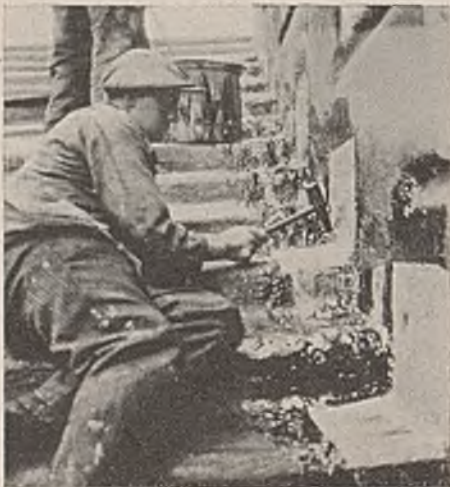
Abb. 7. Anpassen von geriffelten 0,2 mm dicken Dichtungsblechen aus Aluminium an ein- und ausspringenden Ecken am Übergang einer Tribünendecke zur Mauerbrüstung.
