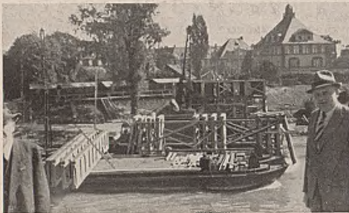
Abb. 31. Anfuhr der Vollwandträger zu Wasser.
