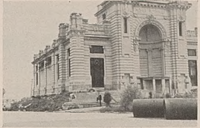
Abb. 12. Condesa-Pumpwerk in Mexiko, Seitenansicht.
