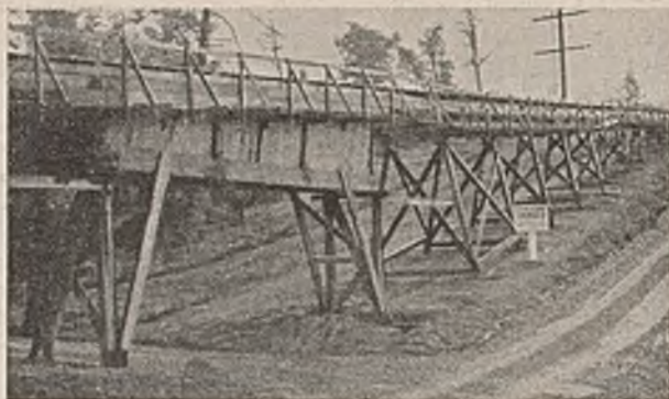
Abb. 2. Überführung der Bandanlage über eine Straße.
