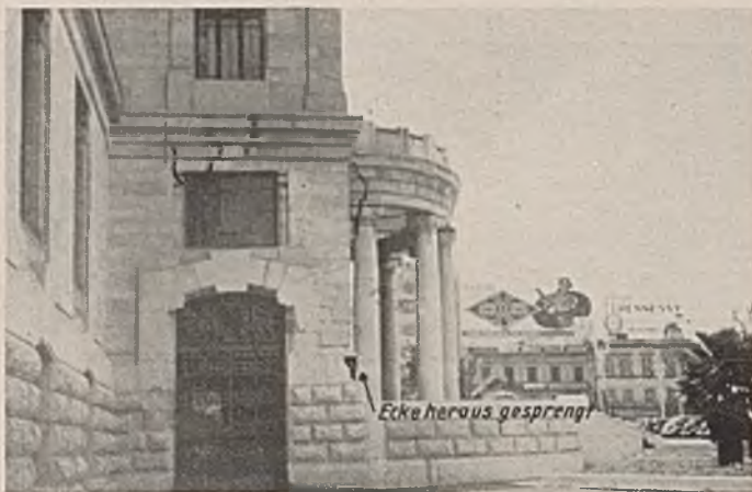
Abb. 9. Nationaltheater in Mexiko, Risse über den Säulen und dem Fenster.
