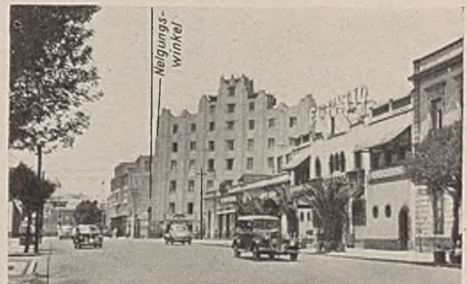
Abb. 10. Wohnhaus in Mexiko, das sich ungleich gesenkt hat.
