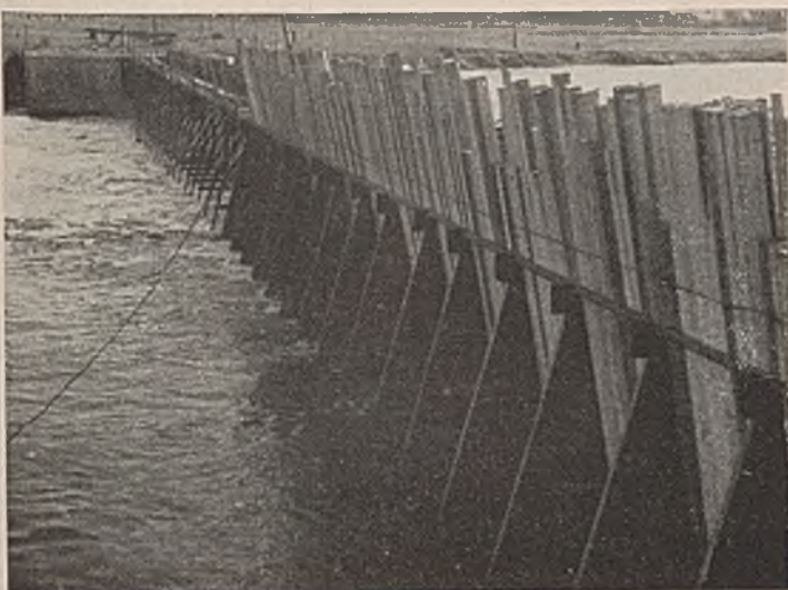
Abb. 10. Behelfsmäßiger Nadelversatz.
