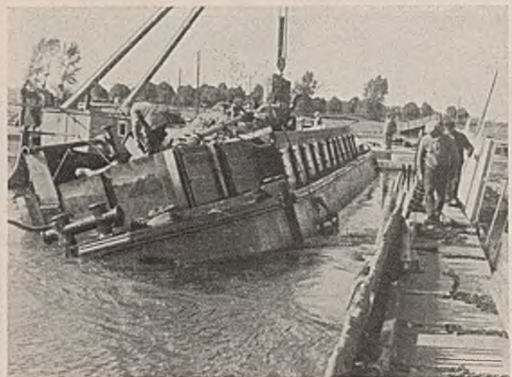
Abb. 11. Aufschwimmen des Fangedammprahmes.
