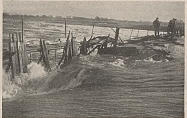
Abb. 2. Schute unmittelbar nach dem Absinken.
