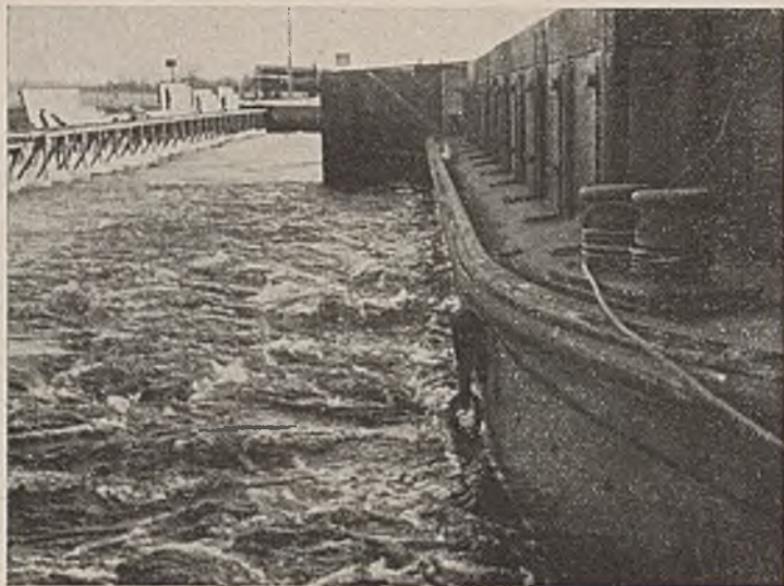
Abb. 5. Zum Fangedamm umgebauter Deckprahm.
