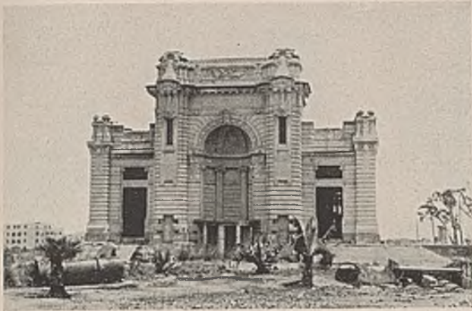
Abb. 11. Condesa-Pumpwerk in Mexiko, Vorderansicht.
