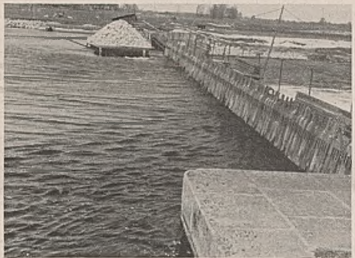
Abb. 9. Die Fangedammschute ist eingebaut, der übrige Teil des Nadelwehres geschlossen.
