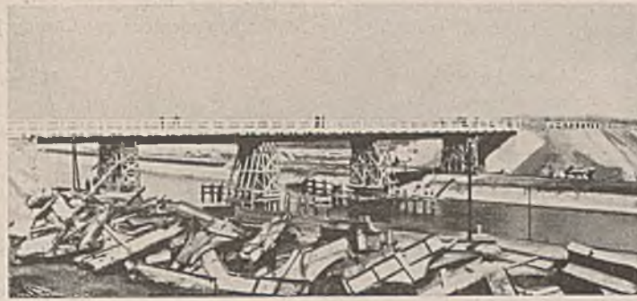
Abb. 5. Von der Technischen Nothilfe erbaute Dauerbehelfsbrücke über einen belgischen Kanal. Im Vordergrund die Reste der gesprengten Stahlbrücke.
