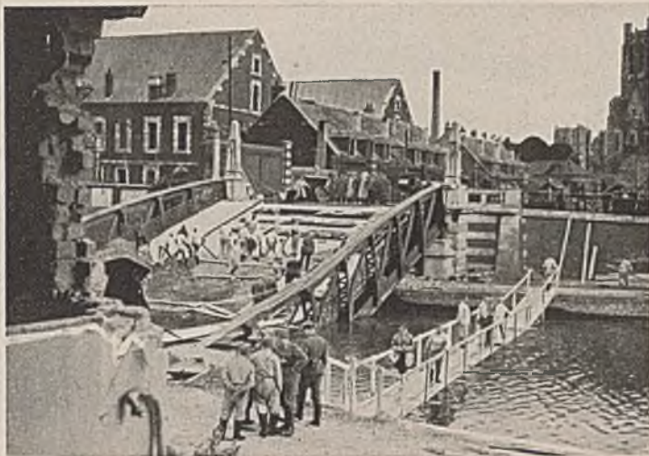
Abb. 1. Beseitigung einer gesprengten Straßenbrücke in St. Omer durch die Technische Nothilfe.
