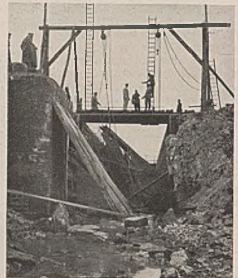
Abb. 4. Aufräumarbeiten in einer gesprengten Kanalschleuse in Ostfrankreich.
