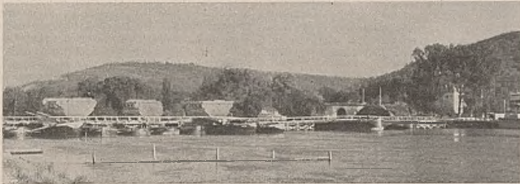
Abb. 6. Von der Technischen Nothilfe erbaute und lange Zeit bediente Schiffsbrücke über die Seine. Im Hintergrunde die Reste der gesprengten steinernen Straßenbrücke.
