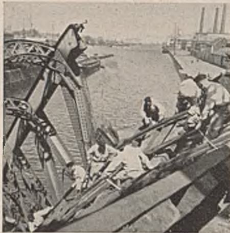
Abb. 2. TN.-Männer räumen Trümmer einer Eisenbahnbrücke aus einem belgischen Kanal.
