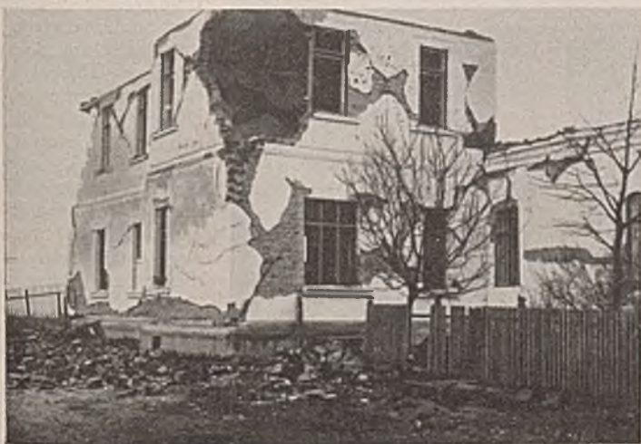
Abb. 2. Zerstörtes Haus bei Ploesti.
