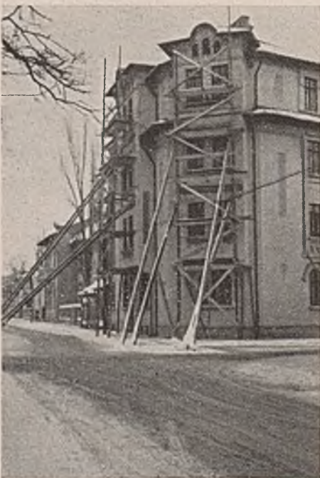
Abb. 15. Behelfsmäßige Abstützung von Gebäuden mit Erkerbauten.
