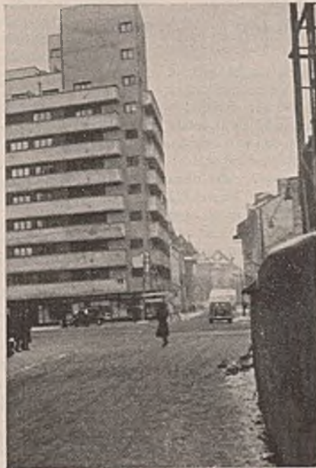
Abb. 19. Beschädigung des Eckpfeilers unter dem zehnstöckigen Turm eines Eisenbetongebäudes.
