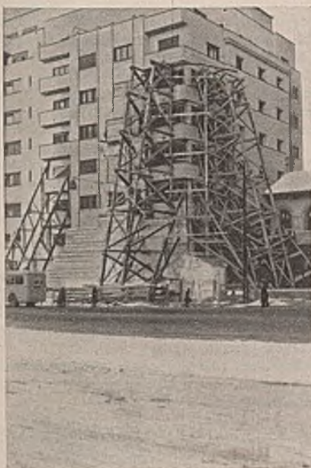
Abb. 18. Sicherung eines beschädigten Eisenbetongebäudes.
