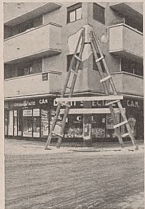
Abb. 20. Einzelheit zu Abb. 18. Die Abstützung ist nicht nach Angabe des Verfassers vorgenommen worden.
