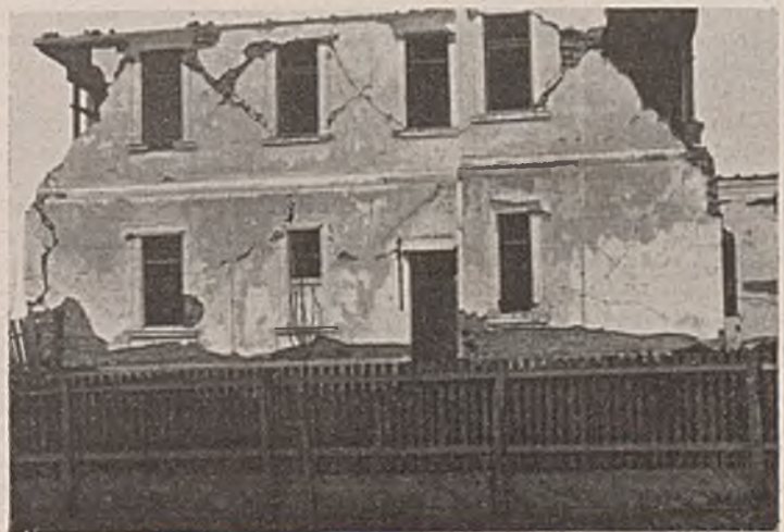
Abb. 4. Zerstörtes Haus bei Ploesti.
