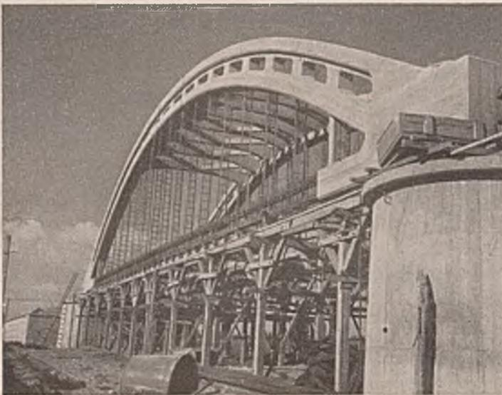
Abb. 8. Der Bogen nach dem Absenken des Lehrgerüsts.
