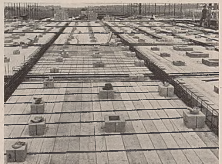
Abb. 11. Verwendung von Betonwerkstücken zur Herstellung sich wiederholender Aussparungen in der Decke eines Schalthauses.
