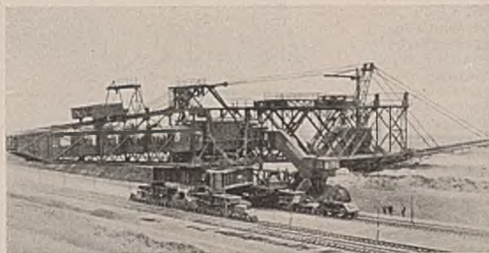
Abb. 27. Uihlein-Absetzer für wahlweise Hoch- und Tiefschüttung mit um 360° schwenkbarem Oberbau (als Tiefschütter arbeitend).
