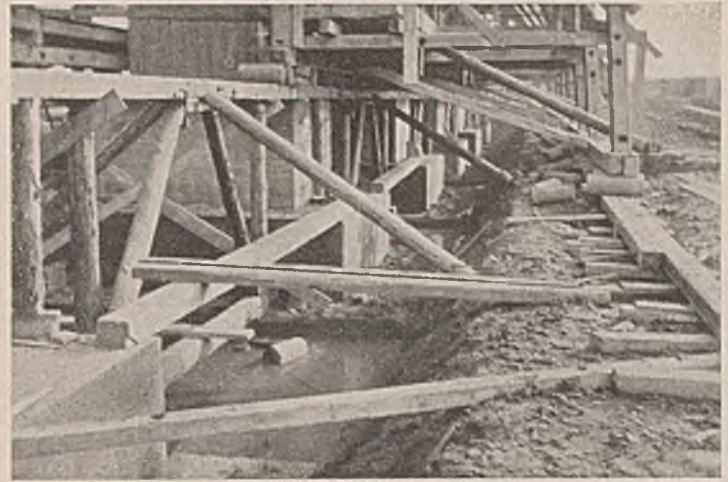
Abb. 42. Fahrerüst für das äußere Arbeitsgerüst der linken Außenwand des Krafthauses II mit den Holzwalzen.
