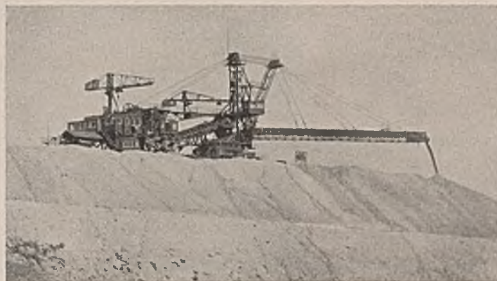
Abb. 29. Absetzanlage für wahlweise Hoch- und Tiefschüttung mit Aufnahmegerät, Zwischenförderer und schwenkbarem Abwurfgerät.
