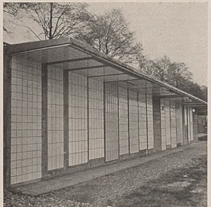
Abb. 19. Proben der Wandbekleidung.
