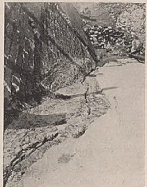
Abb. 11c. Weiterer Rißverlauf auf der rechten Seite. Blickrichtung von oben.
