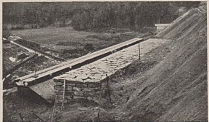
Abb. 3. Das durch einen Steinsatz verstärkte Gewölbeende vor der Wiedereinschüttung.
