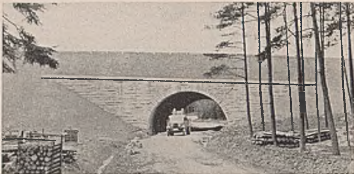
Abb. 17a. Ansicht des Bauwerks.
