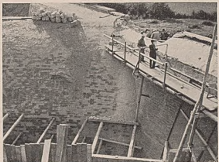
Abb. 25. Beginn der Wiederherstellungsarbeiten.
