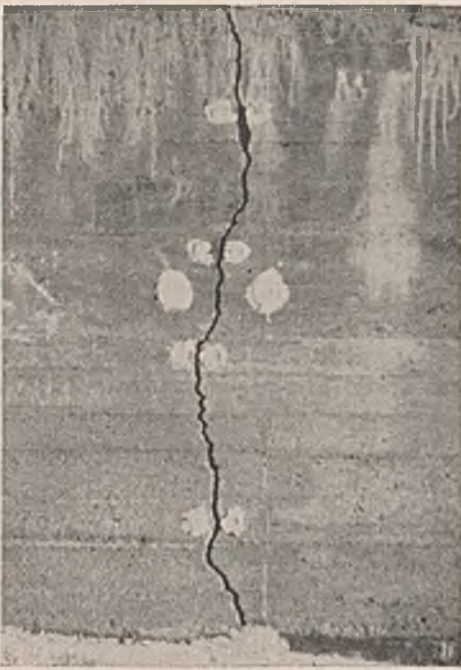
Abb. 20c. Riß II (untere Rißbreite etwa 1 cm).
