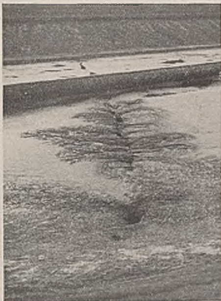
Abb. 2. Bergbau-Zerrungsriß.
