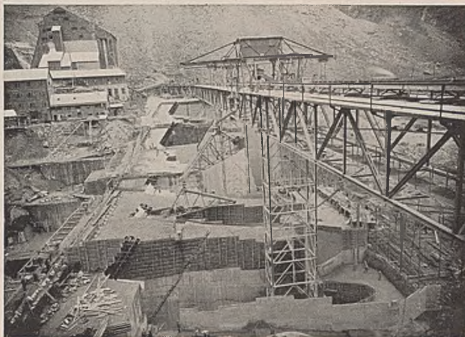
Abb. 1. In der Schweiz erbaute Staumauer mit Hohlräumen, Entwurf Stucki.
