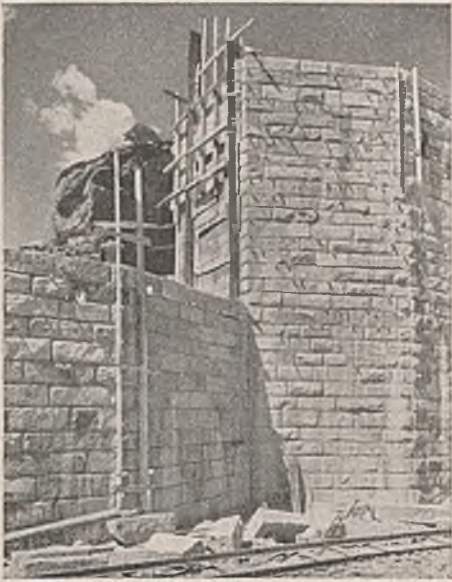
Abb. 6. Bauausführung, Aufmauern zweier Pfeiler.
