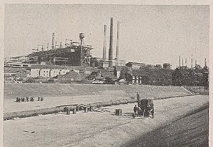
Abb. 8. Die fertige Anlage.
