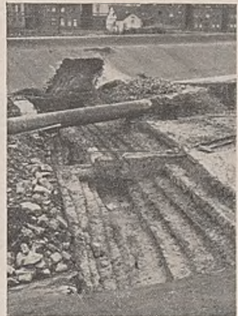
Abb. 4. Ausschachtung über den Zerrungsrisen.
