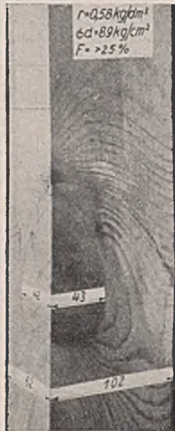
Holz, das als Bauholz nicht mehr zulässig ist.
