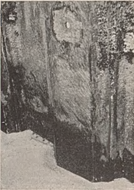
Abb. 23. Buhne 84, Larssen XII. An einem Bohrloch entfernte Blattrostschicht.
