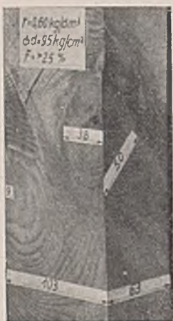
Holz, das als Bauholz nicht mehr zulässig ist.
