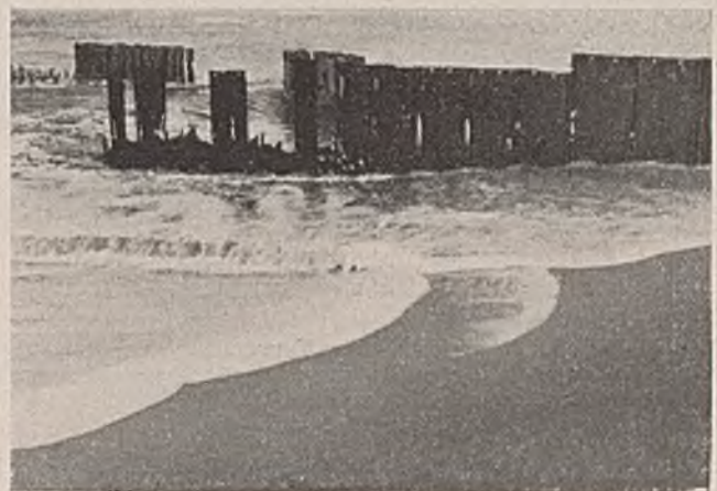
Abb. 21. Weitere durch Sandschliff geschwächte und herausgeschlagene Stahlspundbohlen Größe I.
