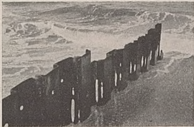
Abb. 19. Bohle 12 aus Larssen Ia. Zerstörungen durch Sandschliff.
