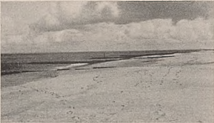
Abb. 25. Mit Buhnen geschützte, gleichmäßig aufgesandete Strandstrecke.
