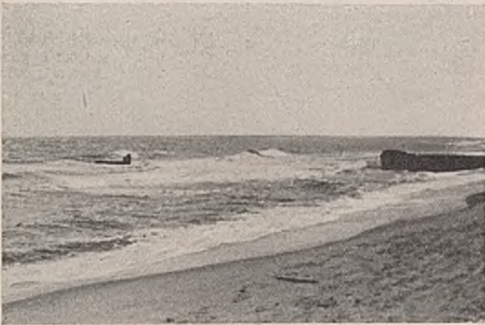
Abb. 7. Durch Umlegen von Bohlen zerstörte Buhnen.
