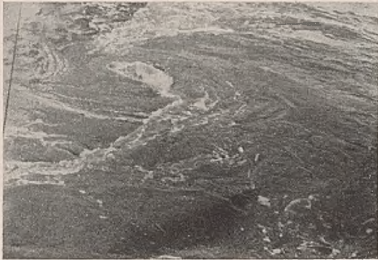
Abb. 13. Wirbel an einer Buhnenlücke.
