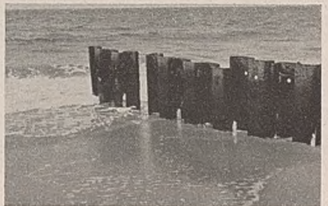
Abb. 17. Sandschliffangriff unmittelbar über dem Strand.
