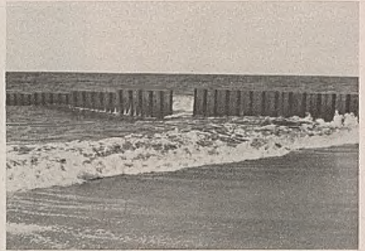
Abb. 14. Lücke in Buhne 42. Bohlen teilweise aus dem Schloß gesprungen.
