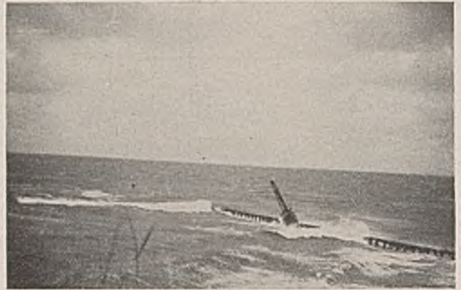
Abb. 24. Buhnenbaustelle am Ellenbogen bei einem Wasserstande von 0,70 m über mittlerem Tidehochwasser im August 1936.
