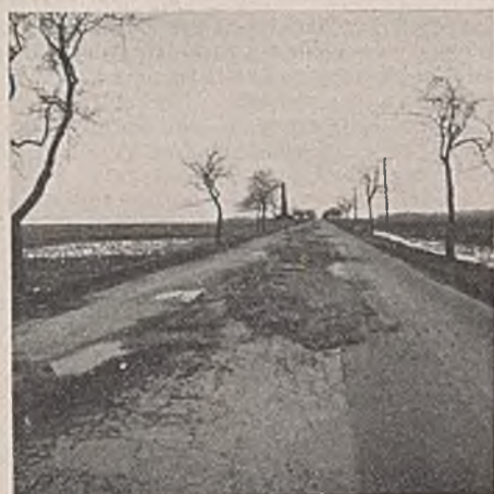
Abb. 4. Schwerere Frostschäden auf einer mittelschweren Decke; Tauschäden nach langer Frostdauer und schnellem Frostauflang. April 1940.
