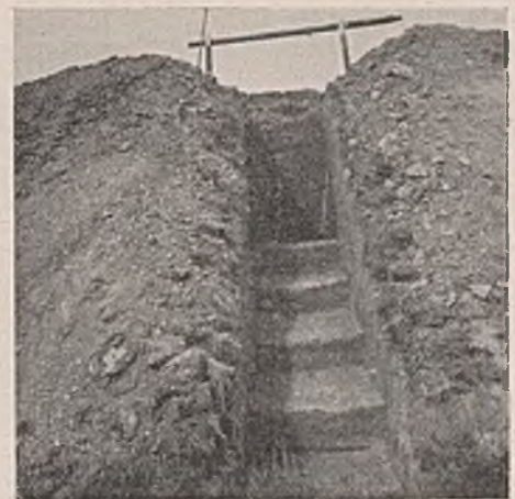
Abb. 10. Schürfrube im Lößlehm eines hohen Straßendamms. Stufen für die Entnahme ungestörter Bodenproben.
