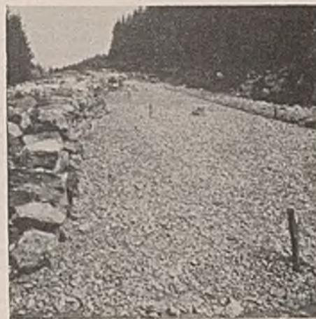
Abb. 21. Unterbettung aus gebrochenem Splitt über lehmig-sandigem Planum beim Bau einer Gebirgsstraße.
