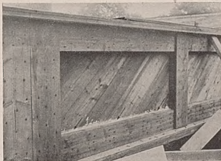
Abb. 1. Ein Gabel-Holzträger mit einem Gemisch aus Tränkungssalzen geschützt.
