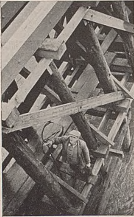
Abb. 2. Aufspritzen von Schutzsalzen.
