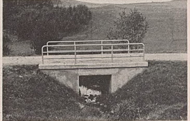
Abb. 13. Trotz brauchbarer Formung wirkt der Durchlaß in dem lieblichen Wiesengrund als Fremdkörper. Eine bessere Behandlung der Sichtflächen und ein nicht zu hohes Holzgeländer würde den Eindruck verbessern.
