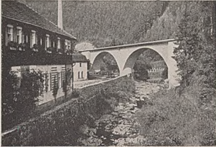
Abb. 18. Die Gesamtform ist befriedigend. Eigenartig erscheint die runde Form des Zwischenpfeilers. Störend ist die Befestigungsart des Mastes in der Kragplatte.
