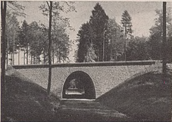
Abb. 1. Das Unterführungsbauwerk ist gut gestaltet und sauber mit Buntsandstein verkleidet. Mit der Waldlandschaft scheint es wie verwachsen. Die Brüstung mit ausladender Abdeckung ruft gute Schattenwirkung hervor. Daß das Gelände fehlt, fällt nicht auf.
