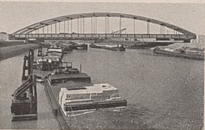
Abb. 59. Der Langerbalken paßt hier als Kanalbrücke im flachen Gelände gut ins Landschaftsbild. Das Bauwerk wirkt kühn und schwungvoll.
