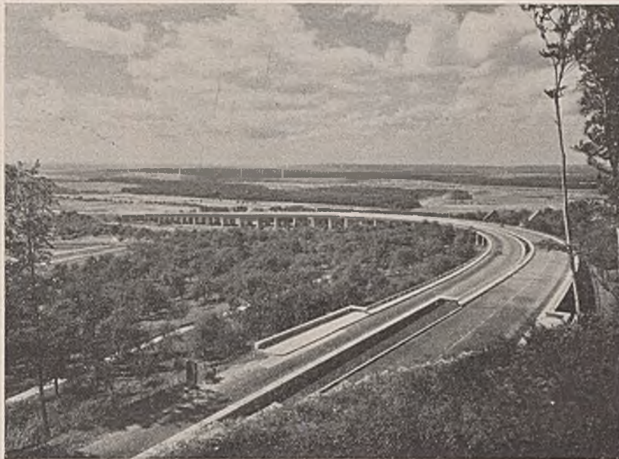
Abb. 29. Auch eine lange Straßentalbrücke läßt sich, wie das Bild zeigt, in erfreulicher Weise in die Landschaft eingliedern.
