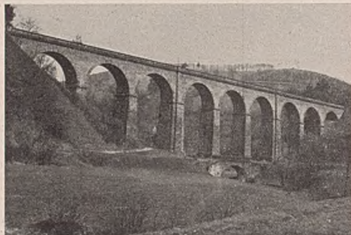
Abb. 8. Dieses bald 60 Jahre alte Bauwerk wirkt auch heute noch in seiner guten Gliederung sehr erfreulich. Man beachte die Aufteilung in drei Bogengruppen zu drei Bogen mit stärkeren Gruppenpfeilern.
