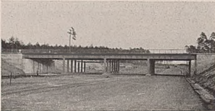
Abb. 46. Die Unterführung einer breiten Straße mit geschweißten Zwischenstützen kann als vorbildlich gelungen bezeichnet werden.
