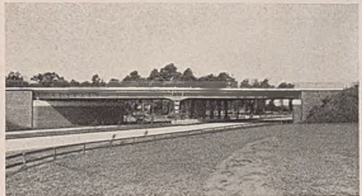
Abb. 32. Die geschweißte Brücke von schiefer Grundriß mit rahmenartig angeschlossenen Mittelstützen ist recht gut gelungen.
