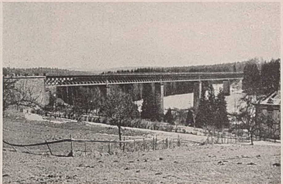
Abb. 51. Diese ebenfalls schon alte Eisenbahn-Talbrücke stört das Landschaftsbild durchaus nicht. Im Gegenteil wirkt sie die Landschaft einrahmend und betonend. Das engmaschige Gitterwerk ist leicht und gefällig, aber dabei doch geschlossen und ruhig. Vorteilhaft ist das Fehlen der Pfosten, so daß keine häßlichen Überschneidungen entstehen. Die Pfeiler erscheinen schlank, aber standfest. Die Flächenbehandlung ist sauber und mit Sorgfalt ausgeführt. Alles in allem kann sich das Bauwerk in jeder Beziehung sehen lassen.
