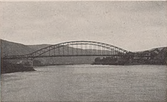
Abb. 58. Die Bogenbrücke ist schlank und leicht gestaltet, sie ist eine Straßenbrücke. Etwas unruhig wirken die Überdeckungen der Außenöffnungen mit dem Fahrband sowie die Überschneidungen der Verbände mit den Bogengurten. Im bergigen Gelände hat ein über der Fahrband liegender Bogen den Nachteil, daß er das Landschaftsbild mehrfach durchschneidet.
