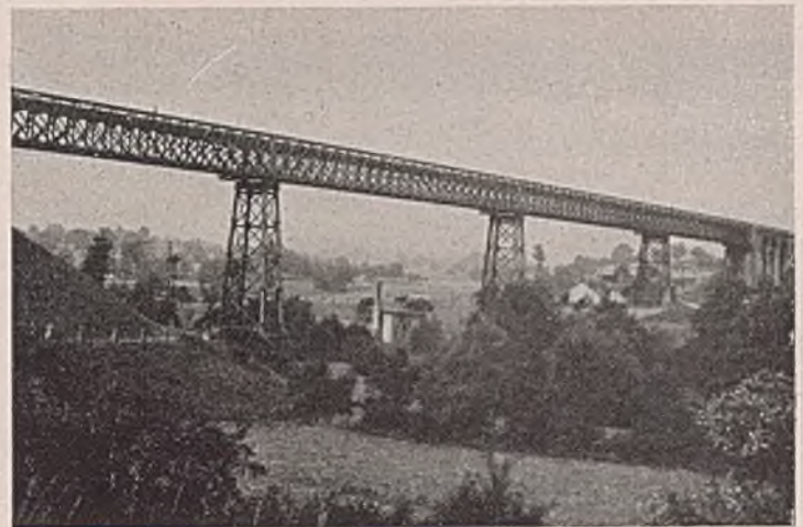
Abb. 53. Weit günstiger fällt diese etwa 70 Jahre alte Talbrücke aus. Im ganzen gesehen erscheint ein geschlossenes Brückenband, weil das Gitterwerk engmaschig ist. Die Pfeiler würden gemauert besser aussehen.
