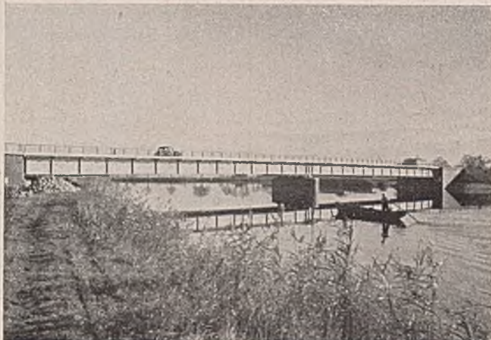
Abb. 54. Geschweißte Flußbrücke, die ausgezeichnet in die Landschaft paßt.
