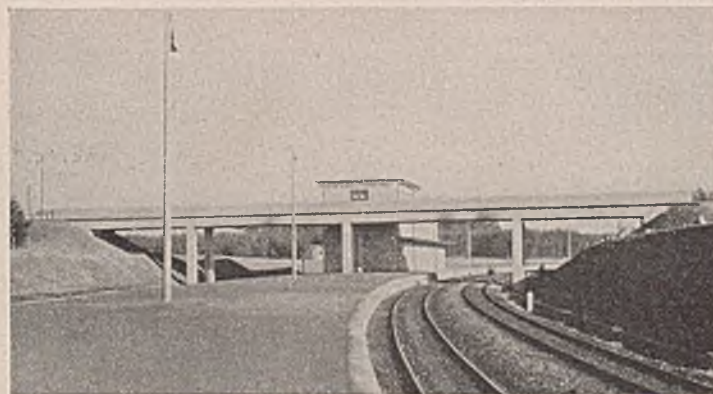
Abb. 22. Eine wundervoll geformte, gut gegliederte Überführung. Die Stärke der Stützen und der Decke mit der Brüstung stehen in gutem Verhältnis zueinander.
