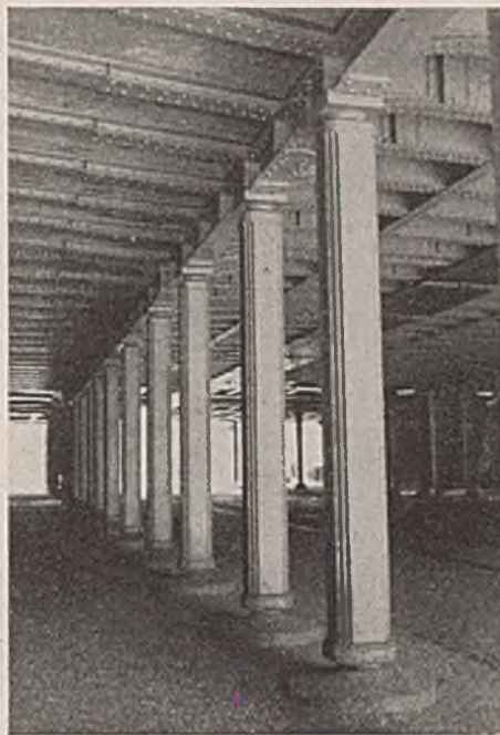
Abb. 40. Ein gutes Beispiel für eine Reihe von Zwischenstützen in geschweißter Ausführung.
