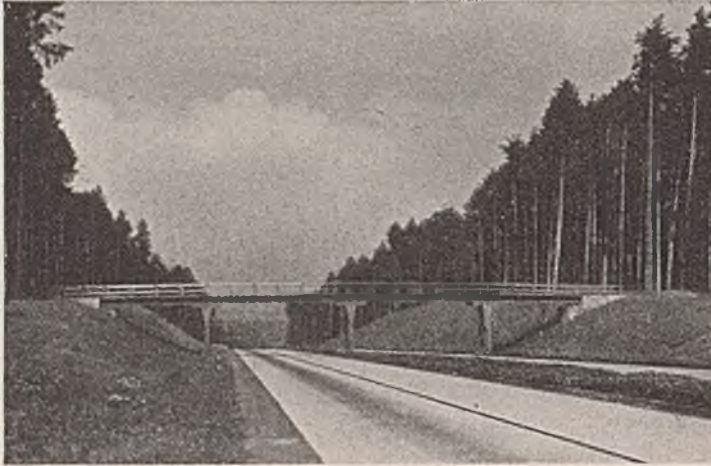
Abb. 12. Der schlichte hölzerne Fußweg wirkt im Walde besonders naturverbunden. Recht gut ist der Übergang von der Stütze zum Sattelholz mittels der Kellstücke.
