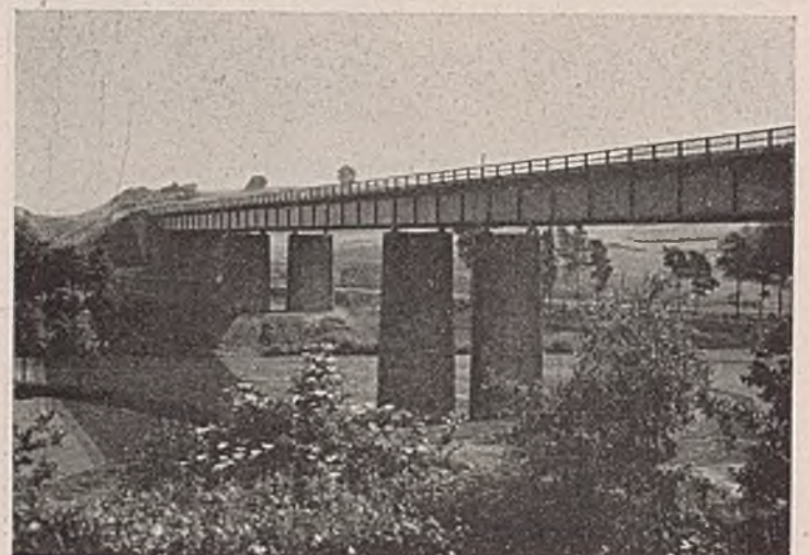
Abb. 49. Auch dieses mit seinen schlanken und doch kräftigen Pfeilern und seinem straffen Stahlüberbau wohl abgewogene Bauwerk bereichert das Landschaftsbild.
