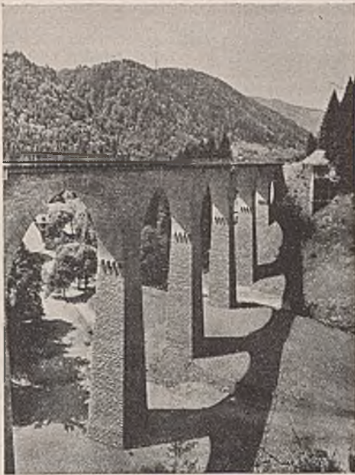
Abb. 9. Die große Talbrücke in einem der schönsten deutschen Waldgebirge unterstreicht den großartigen Eindruck der Landschaft. Zweckmäßig ist auch das schlichte und durchsichtige Geländer; eine massive Brüstung hätte die schlanke Gestalt der Bogen und Pfeiler vielleicht etwas gestört.
