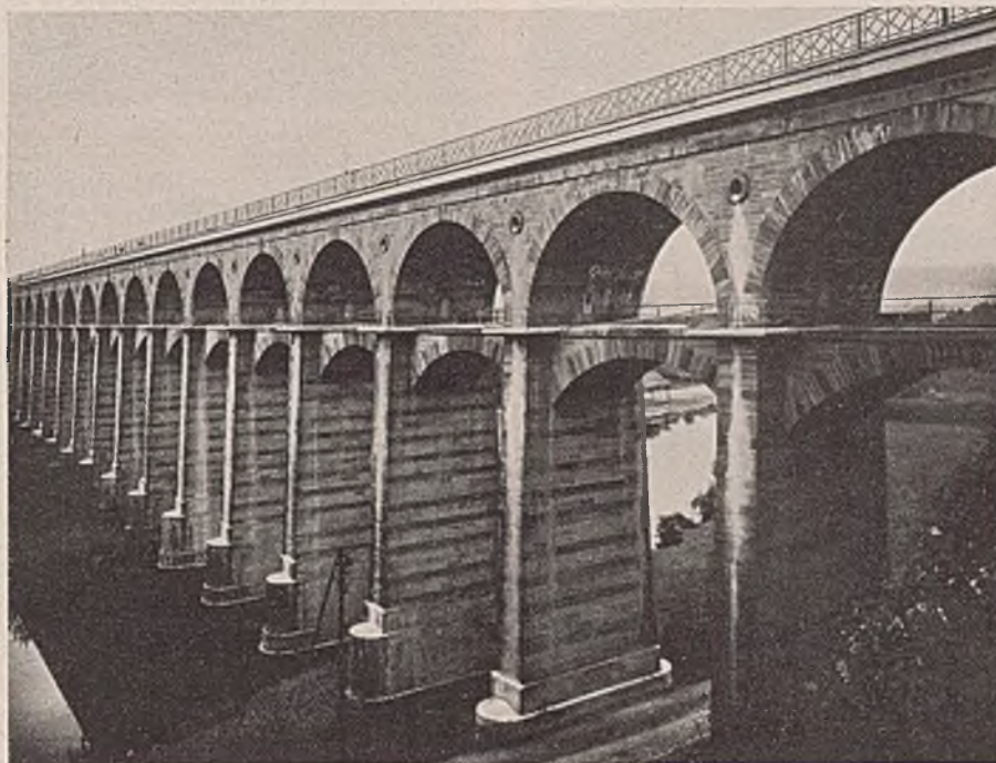
Abb. 11. Auch diese alte Talbrücke kann sich heute noch sehen lassen. Ein schlichteres Geländer, bestehend aus wenigen waagerechten Stäben, wäre freilich vorzuziehen. Die Bogen waren für die heutigen Eisenbahnlasten zu schwach, weshalb zur Entlastung über die Bogen Walzträgerdecken eingezogen wurden. Diese Aufgabe ist mit Geschick gelöst, was besonders die straffe Gesimsführung erkennen läßt. Die Aussteifungsbögen würden mit größerem Stich vorteilhafter aussehen. Der Wasseraustritt hätte anders gelöst werden müssen, um das unschöne dauernde Berleseln der Sichtflächen zu vermeiden.
