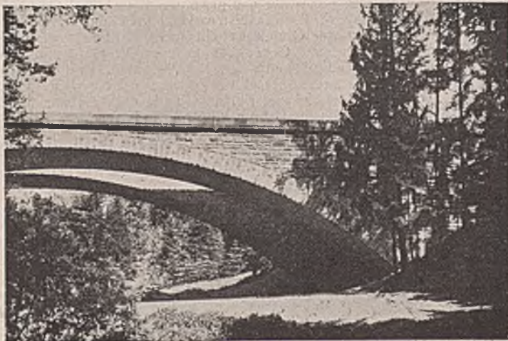
Abb. 3. Das mit kühnem Schwung gestaltete Bauwerk aus neuerer Zeit fügt sich recht gut in seine Umgebung ein. Sehr befriedigend wirkt die schlichte Massivbrüstung mit dem schmalen glatten Gesimsband.
