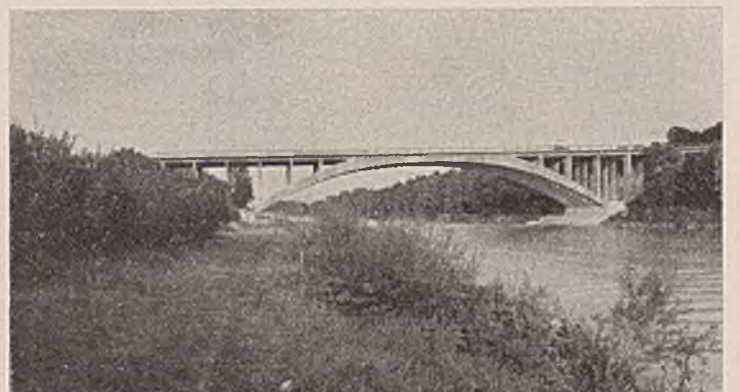
Abb. 28. Die Brücke hat durch weitgehende Auflösung der Bogen- und Aufbauten ein recht schlankes, gefälliges Aussehen erhalten und paßt sich gut der Landschaft an.
