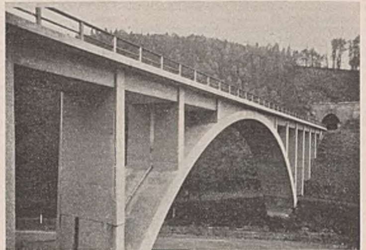
Abb. 25. Ein ansprechendes Bauwerk trotz des Verzichtes auf Steinverkleidung. Der Übergang vom Bogenkämpfer zum Grundkörper scheint nicht ganz gelöst zu sein.
