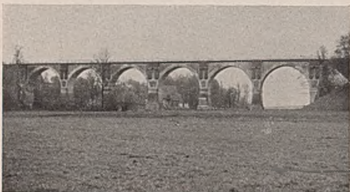
Abb. 27. Das in seinen Umrissen befriedigend ausgebildete Bauwerk ist durch die Putzbehandlung der Außenflächen und die wie angeklebt wirkenden Kanzeln verunstaltet worden.
