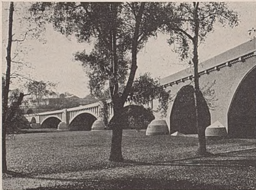
Abb. 26. Obgleich diese Flußbrücke schon etwa 30 Jahre alt ist, also sozusagen aus der Jugendzeit des Stahlbetons stammt, ist sie dank ihrer vorbildlichen Gestaltung auch heute noch höchst sehenswert. Recht schön sind z. B. die Pfeilervorköpfe, bemerkenswert gut die Behandlung der Sichtflächen. Die senkrechte Unterteilung der Gewölbestrirnen würde man heute vielleicht als entbehrlich ansehen.
