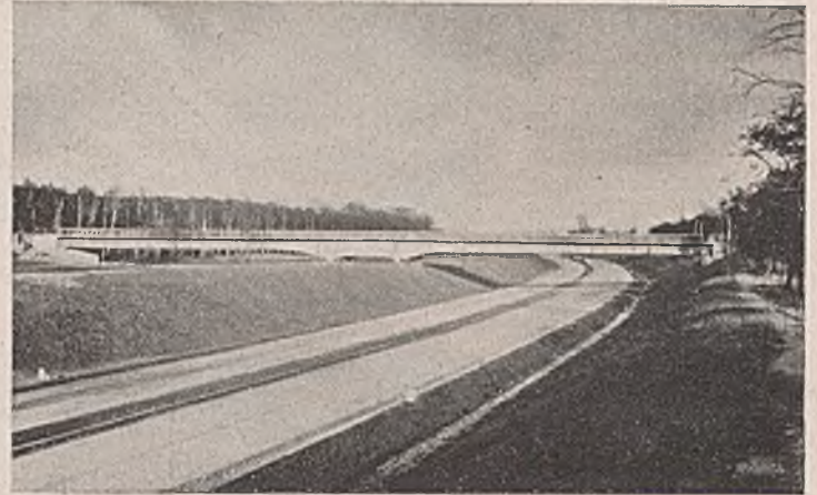
Abb. 34. Ein kühnes, gut geformtes Überführungsbauwerk in geschweißter Ausführung.
