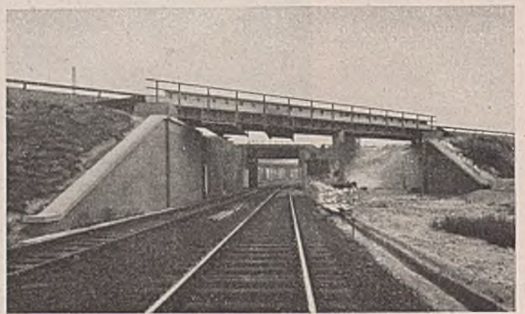
Abb. 36. Dieses Bauwerk ist wenig gelungen. Besonders der Übergang zum Bahndamm und die Geländerabschlüsse sind nicht gelöst.
