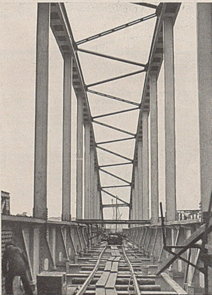
Abb. 5. Durchblick durch den Überbau über der großen Flußöffnung.
