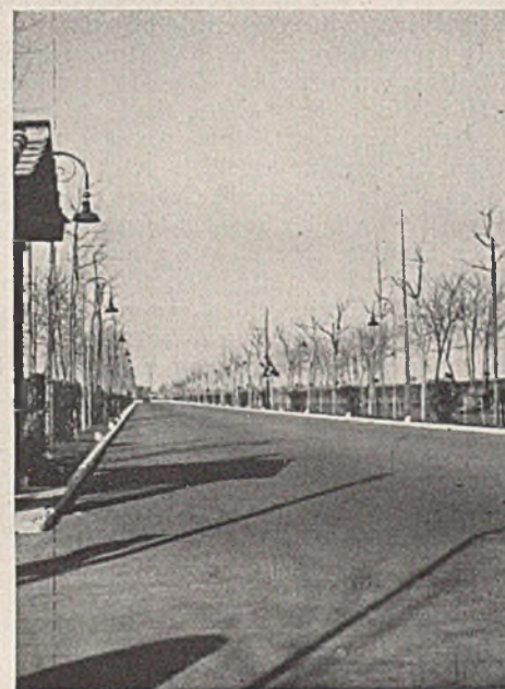
Abb. 11. Autobahn Rom—Ostia mit weißgekalktem, erhöhtem Bordstein.
