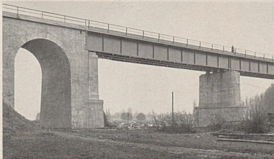
Abb. 10. Zweigleisige Eisenbahnbrücke über einen Fluß. Neue Überbauten.
