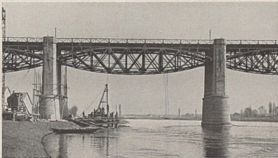
Abb. 9. Zweigleisige Eisenbahnbrücke über einen Fluß. Alte Überbauten.
