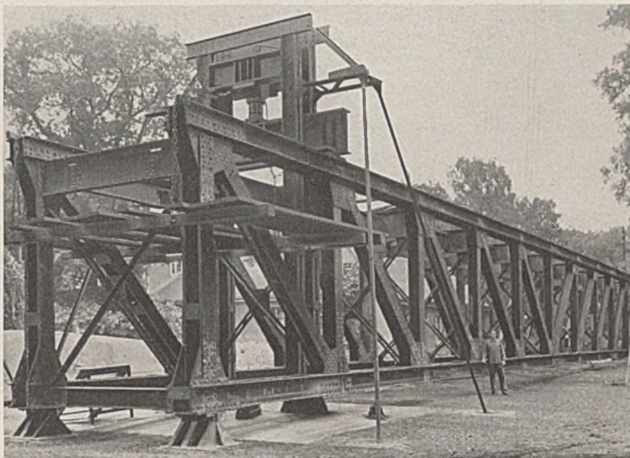
Abb. 1. Fachwerkversuchsbrücke in der Materialprüfungsanstalt der Technischen Hochschule Karlsruhe.
