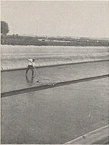
Abb. 9. Abschieben der liegengebliebenen dünnen Schlammschicht mittels Handkratzers nach der Mittelrinne, wo er von selbst weiterfließt.
