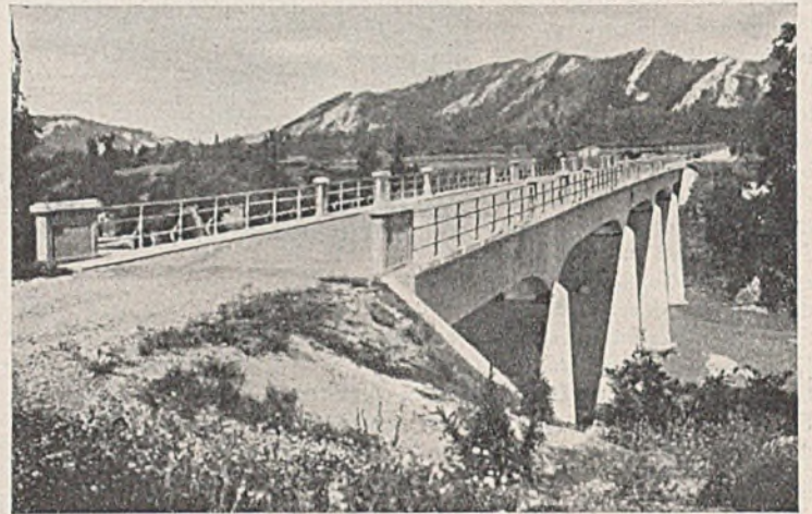
Abb. 2. Brücke über den Arzen.
