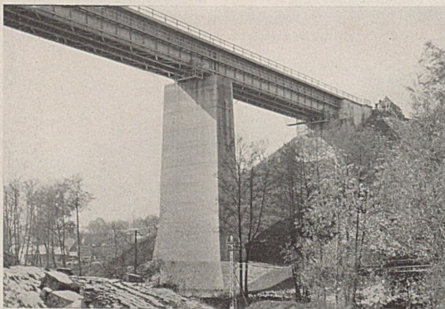
Abb. 13. Zweigleisige Eisenbahnbrücke über ein Tal. Neue Überbauten.
