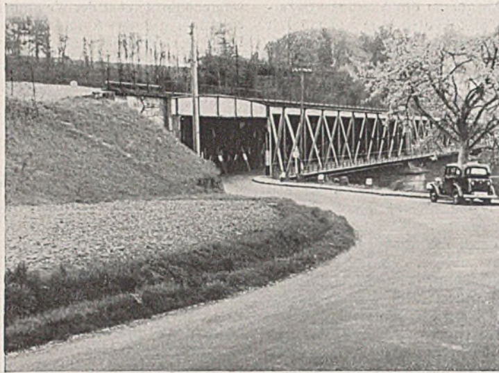
Abb. 1. Alte Brücke. Bauwerk I.
