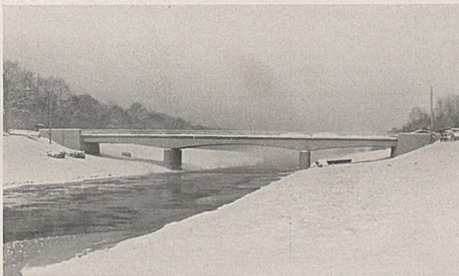
Abb. 13. Neue Brücke. Bauwerk 2.
