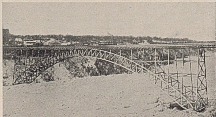
Abb. 4. Niagara-Brücke vor dem Einsturz.
