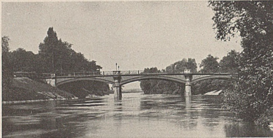
Abb. 10. Königsbrücke vor der Verbreiterung.
