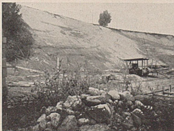
Abb. 1b. Böschung vor der Rutschung, Fall 1.
