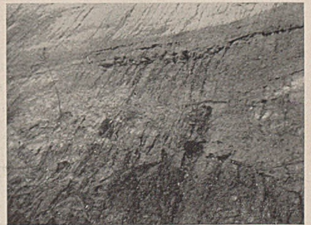
Abb. 1c. Böschungsteil mit Rutschungsanfängen, Fall 1.
