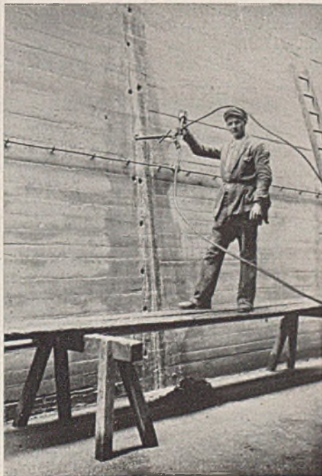
Abb. 3. Ansetzen des Dichtungsgerätes. Lichtbilder: Wasserstraßendirektion (3).
