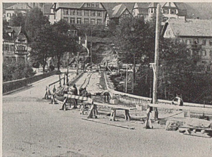
Abb. 24. Erster Teil der Brücke (rechts) im Bau.
