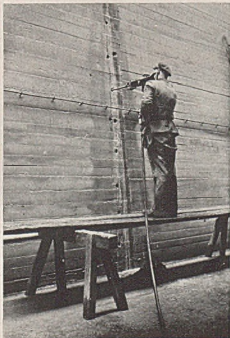
Abb. 2. Bohren der Einpreßlöcher.
