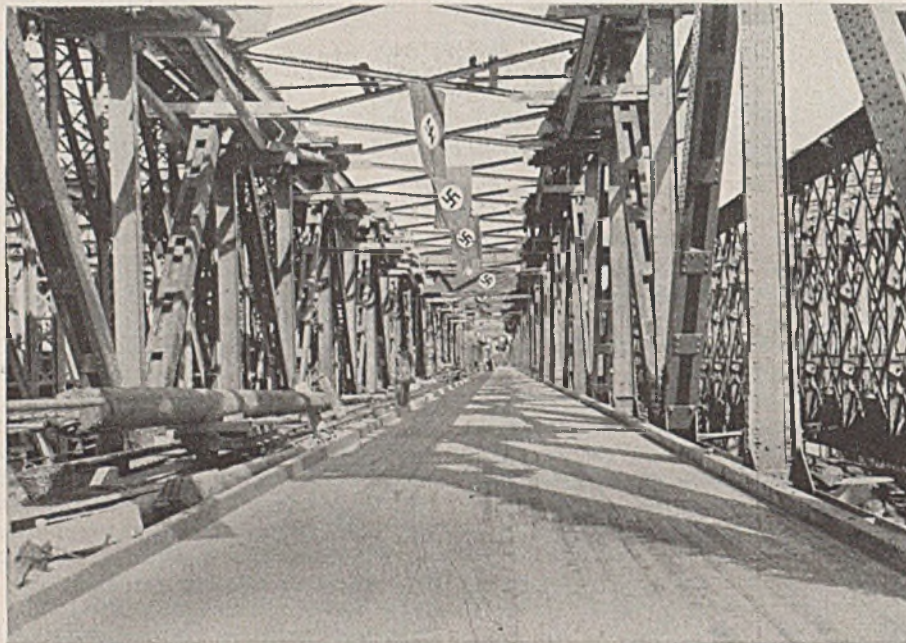
Abb. 9. Sicht durch die Brücke am Eröffnungstag. Die Fahrbahn wird vorläufig nur durch einen Holzbohlenbelag gebildet, die Tragkraft war jedoch für 24-t-Fahrzeuge ausreichend. Aufgenommen am 5. Oktober 1938.
