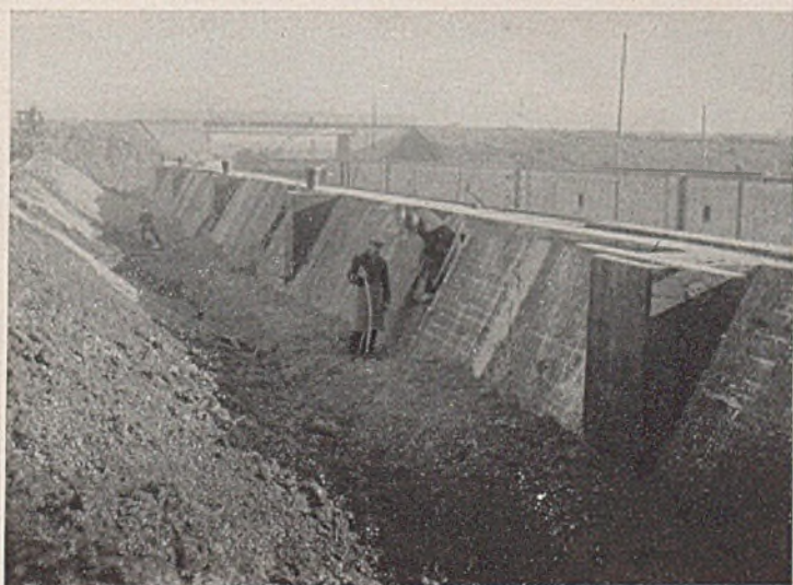
Abb. 19. Einbringen der Kieshinterfüllung und der Tondichtung.
