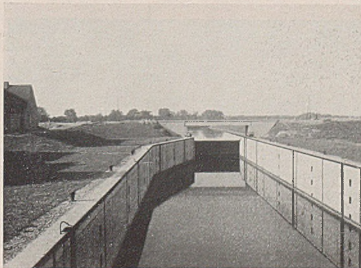
Abb. 20. Schleuse hinterfüllt und im Rohbau fertig.
